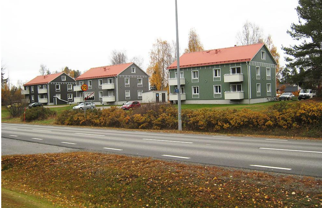
Bild 2.2-2. Bostadsområdet Lugnet ligger längst i söder på den aktuella sträckan av väg E12.
