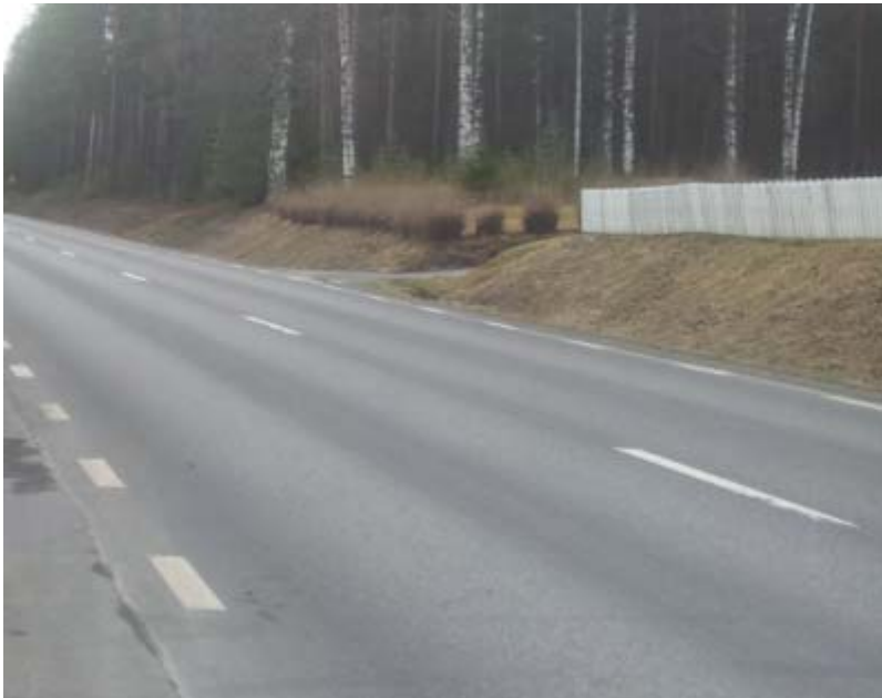
Bild 11; visar exempel på där det kan bli markintrång på den västra sidan av E12.
