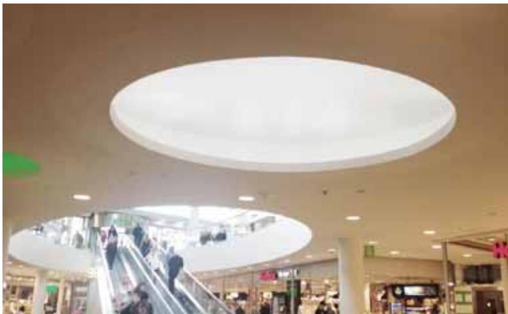
FIGUR 7.21. Exempel på ljusbrunn i undertak, Frölunda Torg.
