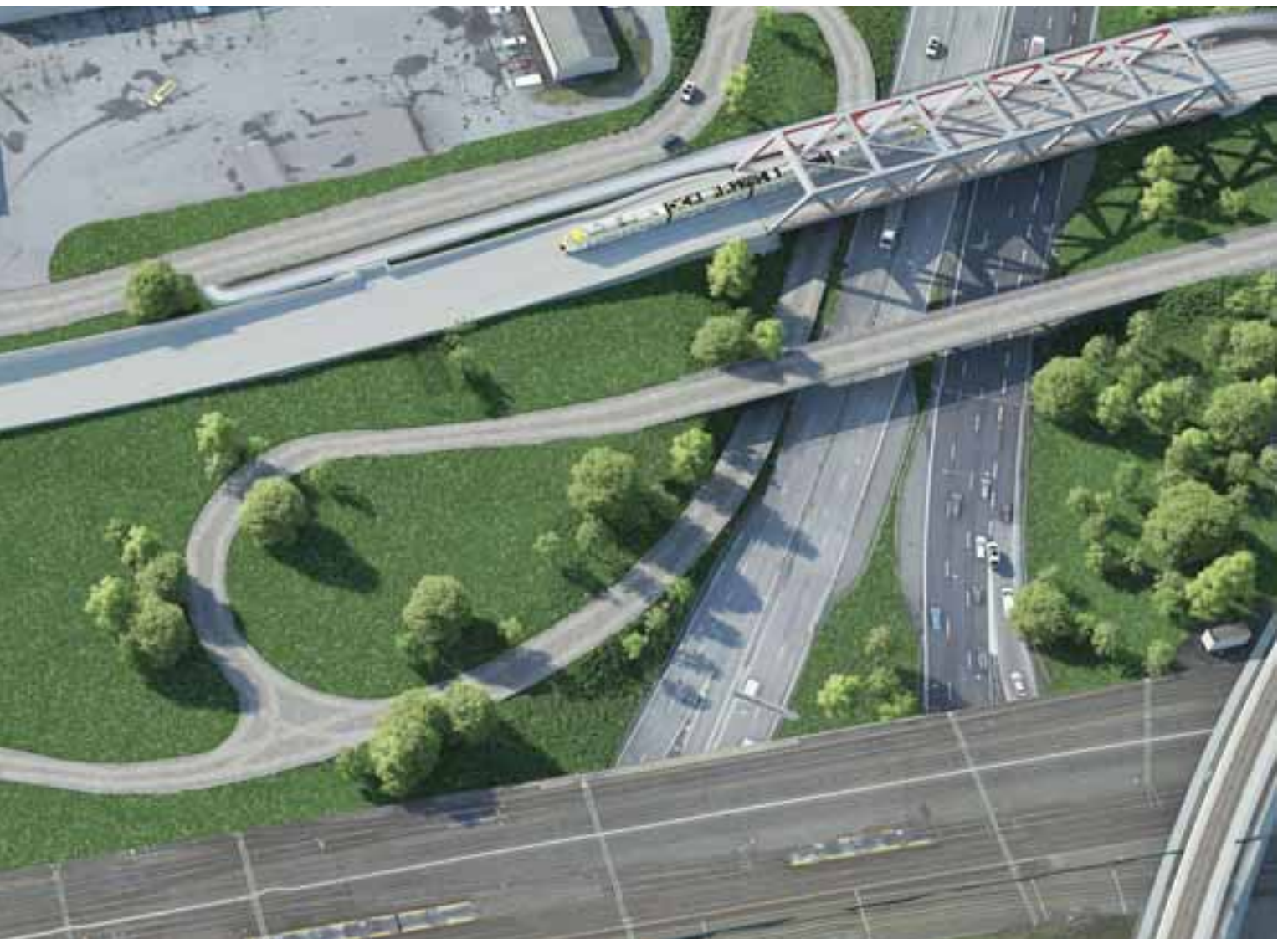
dels via GC-väg över tunnelmynningen och vidare på ombyggd vägbro över E6.
