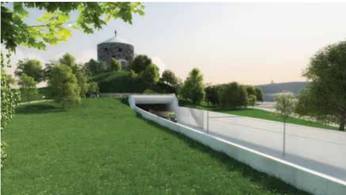
FIGUR 4.39. Illustrationsexempel som visar tunnelmynningen i Gullberget. Mynningen utformas som en utanpåliggande ram som omsluter tråget.
