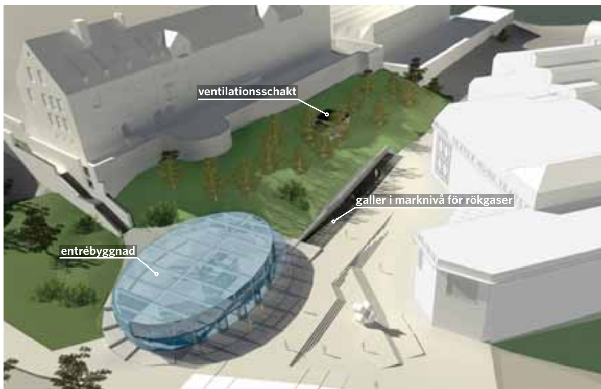
FIGUR 7.50. Illustrationsexempel på entrébyggnad vid Renströmsparken med galler i mark för rökgaser och ventilationsschakt i den sluttande terrängen.
