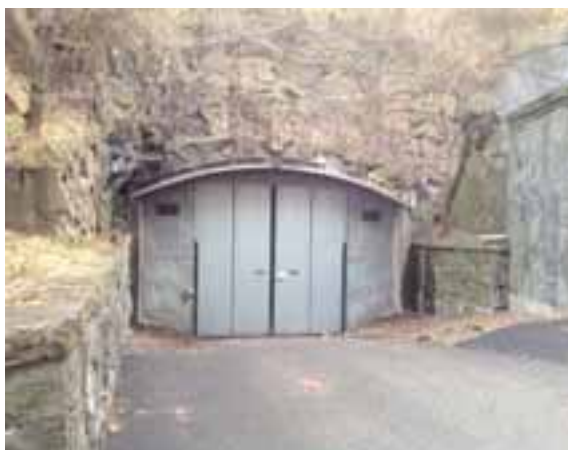
FIGUR 6.36. Foto som visar tunnelmynning Kvarnberget. Befintligt utseende.
