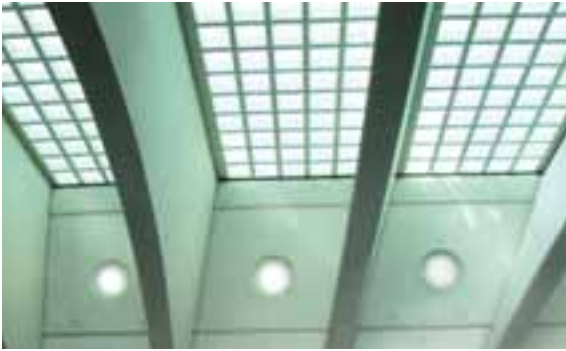
FIGUR 5.14. Glasbetong
