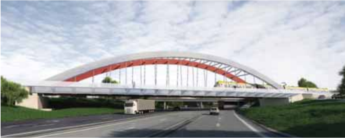
FIGUR 4.36. Illustrationsexempel som visar alternativ utformning av E6 bron som bågkonstruktion. Påhängd cykelbro illustreras i framkant.
