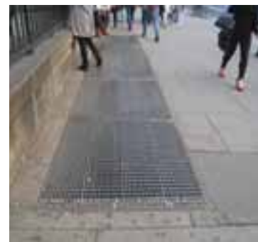
FIGUR 7.52. Exempel tryckutjämnings-schakt i marknivå, NYC.
