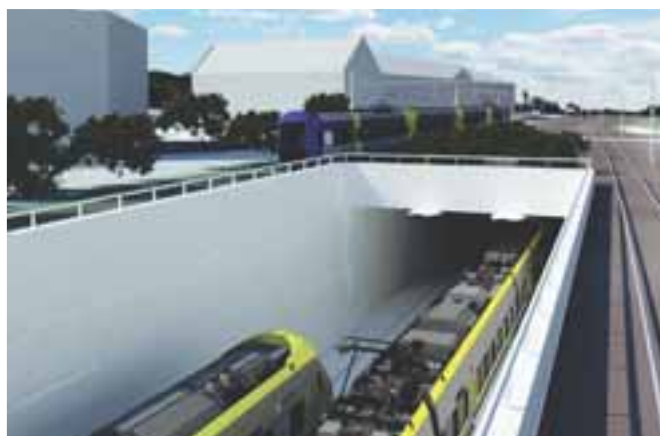
FIGUR 7.66. Illustration av trågväggar och räcken vid betongtunnelns mynning.
