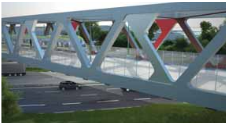
FIGUR 1.1. Olskroken planskildhet. Illustrationsexempel som visar föreslagen fackverksbro över E6:an.
