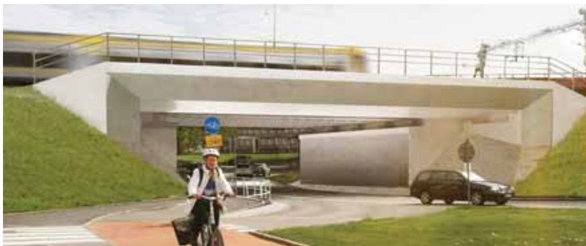
FIGUR 4.22. Illustrationsexempel som visar betongbron över Gamlestadsvägen sedd från norr. De fasade kanterna och lutande planen markerar en tydlig ram runt passagen. Brokonernas utförande under bron gestaltas i likhet med brokoner vid Partihallslänken och stensätts.
