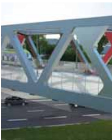
FIGUR 4.16. Transparentt bullerskydd integrerat i broutformningen, i figur som räcke.
