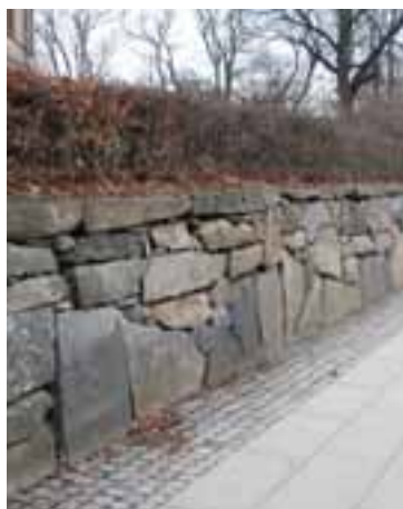
FIGUR 4.17. Exempel på utförande av naturstensmur.
