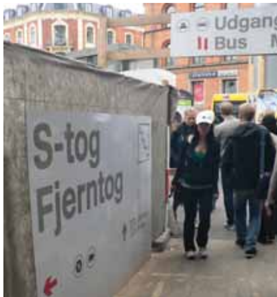
FIGUR 8.27. Under bygget av de tre stationerna, men också vid öppna schakt på linjen, finns risk att avskärmning av arbetsområden gör det svårt att hitta snabbaste vägen till kollektivtrafiken. Skyltningen kommer att vara viktig att hålla uppdaterad och samordna med Västtrafik och andra aktörer liksom att planera så att siktlinjer mellan gångstråk och hållplatser hålls så öppna som möjligt, Köpenhamn. Foto: Ramböll
