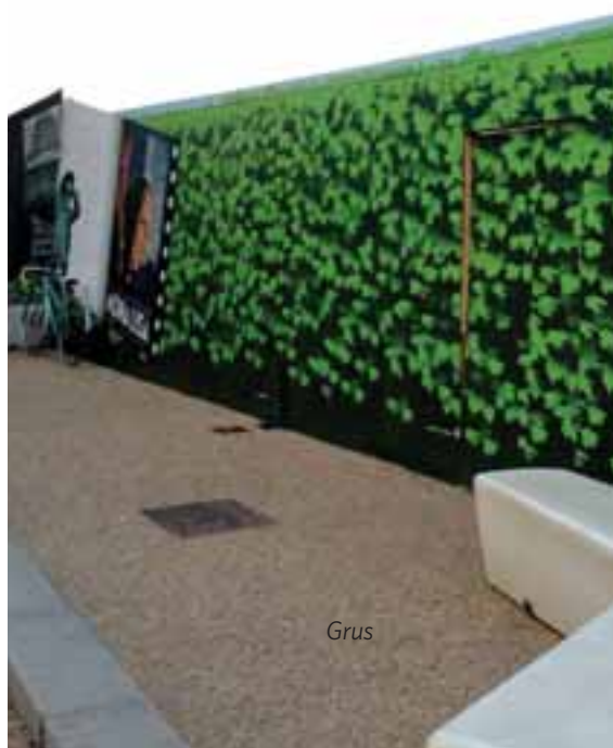
FIGUR 8.10. Plank kan utföras med klängväxter, med gröna kassetter eller, som här, med stiliserad grönska. Markbeläggningen av stabiliserat grus förstärker känslan av park, London.
