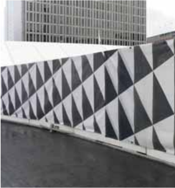
FIGUR 8.3. Ett bra exempel på platsspecifik utformning av avskärmning kring byggarbetsplats; det välkända plattmönstret på Sergels torg tryckt på perforerad meshvinyl, Stockholm. Foto: Ramböll
