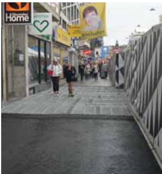
FIGUR 8.14. Gångvägar förbi byggarbetsplatser behöver vara tillräckligt breda för att undvika trängsel. Cyklar ska ha separata vägar. Avskärmningens yta ska tåla beröring och se bra ut på nära håll, Stockholm. Foto: Ramböll
