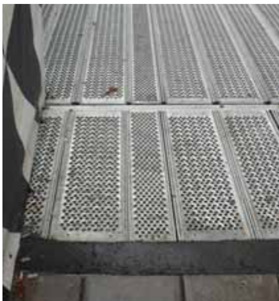
FIGUR 8.15. Tillfälliga markbeläggningar ska vara stabila, halkfria och inte skramla. Nivåskillnader ska fasas som till exempel här med en asfaltkil. Planket ska ansluta bra mot marken, Stockholm. Foto: Ramböll
