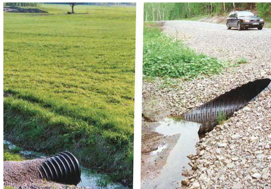
Figur 26. Exempel på trumma som sticker ut ur slänt kontra följer släntlutningen. Foto: ur Dalslands vägmiljöer - Gestaltungsprogram.
