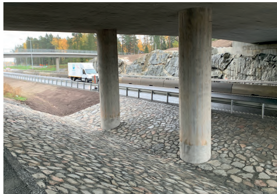
Figur 21. Exempel på stensättning i slänt under bro utförd med ordnad sprängsten. Foto: Trafikverket (Rotebroleden, Stockholm).
