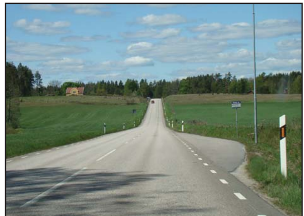
Krön som profiljusteras före betongindustri vid Fiskareby.
