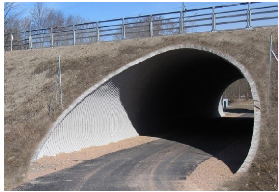
Figur 10. Exempel på rörbro där röret är snedskuret för att skapa bättre ljusförhållanden i tunneln. Rörets kant är täckt med. Foto: ViaCon 2009, (bilden har redigerats).
