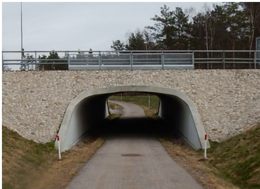
Figur 9. Exempel på valvbro med betongtäckt kant och stensättning mellan ovansida bro och vägkant. SO Vanneberga vid Rosenlund på rv 21 11-1006-1
