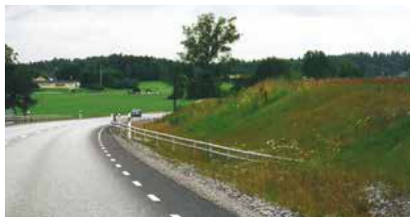
Räckesänden svängs ut och förankras i bakslänten, en både trafiksäker och estetiskt tilltalande lösning. Källa: Vägen, en bok om vägarkitektur.
