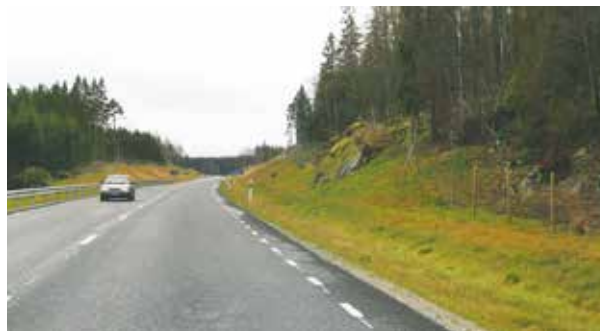
Slänter klädda med avbaningsmassor. Källa: Vägen, en bok om vägarkitektur.
