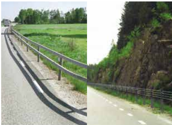
Rörräcken och stållineräcken är exempel på räckestyper som båda har god genomsikt. Källa: Vägen, en bok om vägarkitektur.
