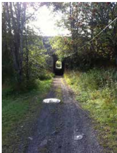
Bild 12. Befintlig gångtunnel under järnvägsbanken.
