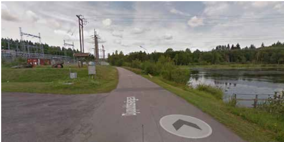
Bild 21. Djupuddsvägen. Vy mot norr och broläget med ställverket till vänster och sjön Södra Hörken till höger i bild. Foto Google Map.
