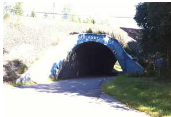
Bild 13. "Dalporten". Befintlig vägport under järnvägen
