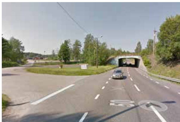
Bild 22. Infart gocart banan och järnvägsbron vid Stubinfabriken. (Fotografi GoogleMap)
