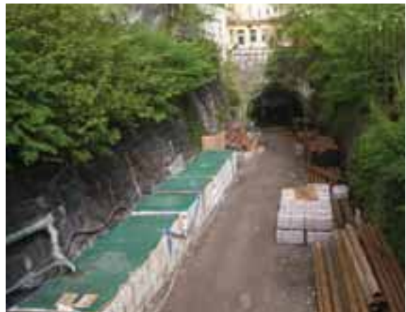
FIGUR 12.3. Bild från byggskedet vid Fatbursparken, Citybanan Stockholm i maj 2013 då rening av läns hållningsvatten i gjordes genom en reningsanläggning placerad i containers till vänster i bilden.
