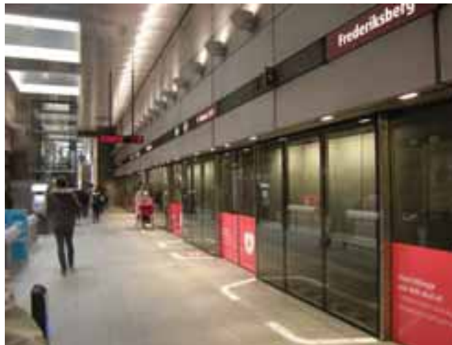
FIGUR 17.2. Från stationsmiljö vid Köpenhamns metro där plattformsavskiljande dörrar används mellan spår och plattformar. På bilden syns dessa i stängt läge.
