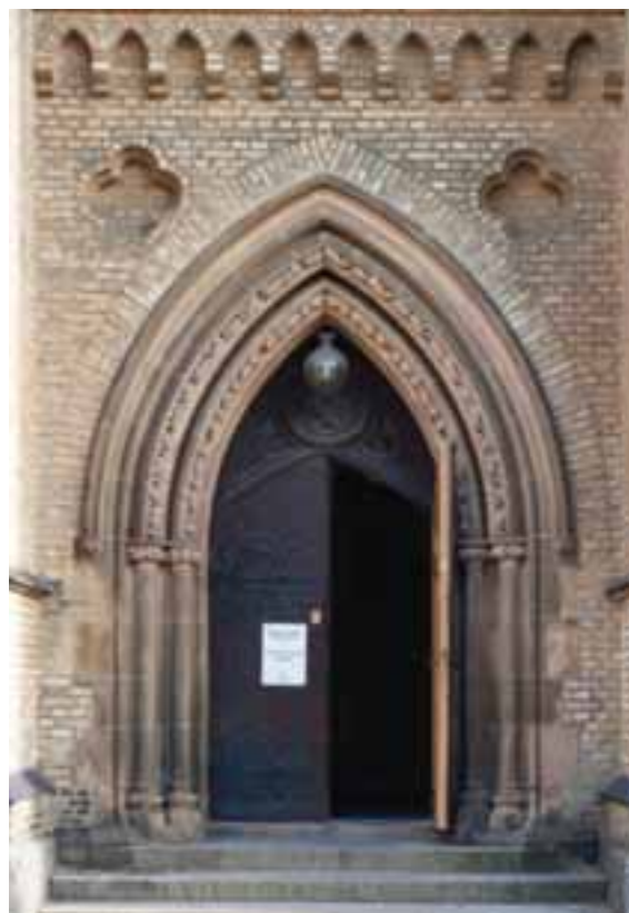
FIGUR 8.15. Hagakyrkan, har en känslig exteriör med bland annat tegel och detaljrika stenarbeten.
