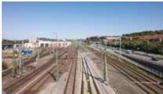
FIGUR 14.6. Befintligt spårrområde och E20 med bebyggelsen i Olskroken till höger.
