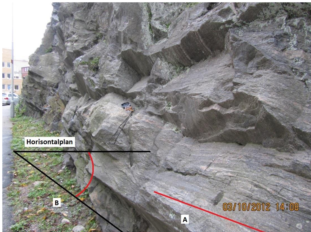
Figur 4-2. Bergskärning med gnejs. "A" visar foliationen, vilket då avser bergets storskaliga strukturella riktning. Strykningens riktning anges med kompassriktning. "B" visar bergets stupning, vilket i detta fall utgörs av en spricka längs foliationen. Stupningen är vinkeln mellan horisontalplanet och sprickplanet längs foliationen. (Foto Maria Fransson)
