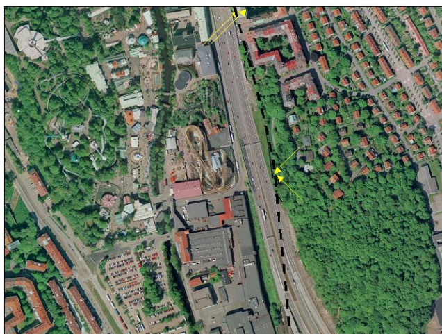
Figur 3.11 Bilden visar tunnelns södra del och två mätpunkter i Hemtjänsts lokaler på Påskbergsgatan (fastighet 33:10) samt två mätpunkter nästan rakt ovanför tunneln med enstaka meter bergtäckning - invid gångvägen strax öster om Nellickevägen (fastighet 750:759).
