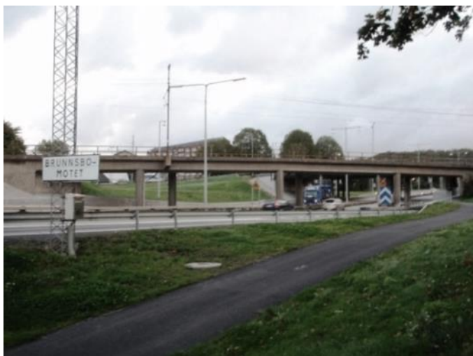
Figur 19 Järnvägsbro för Bohusbanan över Lundbyleden sett från väster.
