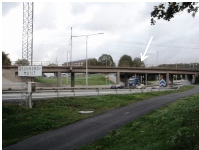
Figur 23 Järnvägsbro för Bohusbanan över Lundbyleden sett från väster.
