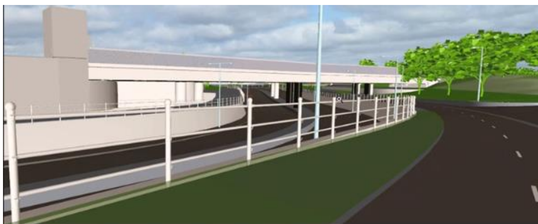
Figur 16. Illustration över järnvägsbron över Backavägen utan bullerskyddsskärm (ovan) och med en bullerskyddsskärm med höjd på 2,3 meter över rälsöverkant. Notera att skärmen måste vara tät och ljudabsorberande, och kan därför inte vara av genomsynligt material.
