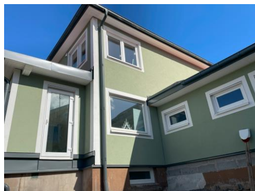
Figur 2. Uteplats (under byggnation) söder
