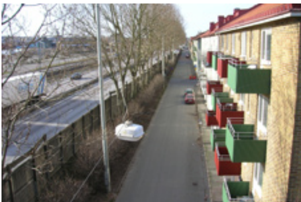
I Kvillestaden ligger bebyggelsen nära Lundbyleden. Rörstrandsgatan har ett trångt gaturum och bullerskärmen utgör en visuell barriär.
