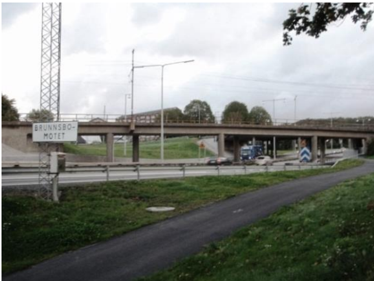
Figur 14 Järnvägsbro för Bohusbanan som korsar Lundbyleden.
