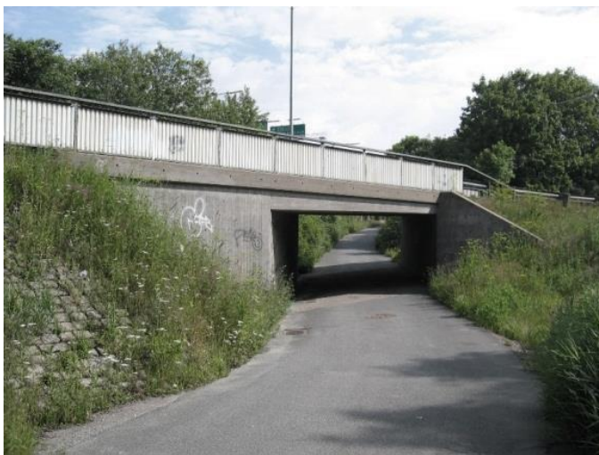
Figur 16 Bro över gång- och cykelväg.
