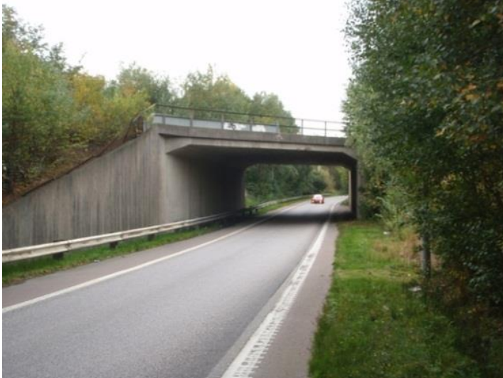
Figur 17 Bro för Bohusbanan över ramp som leder trafik till E6 norr.
