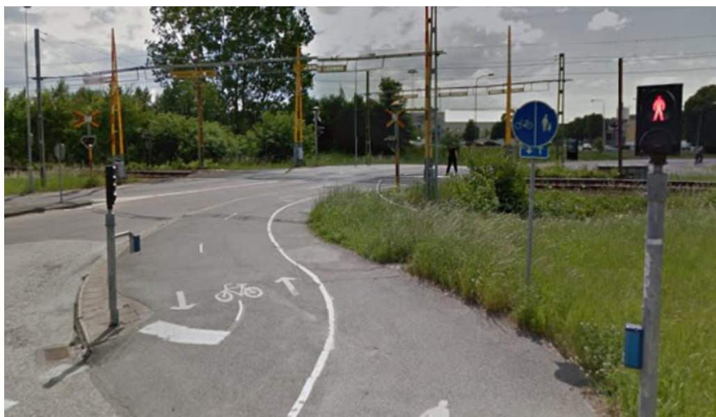
Figur 3 Gång- och cykelväg vid plankorsning Bohusbanan/Backavägen.
