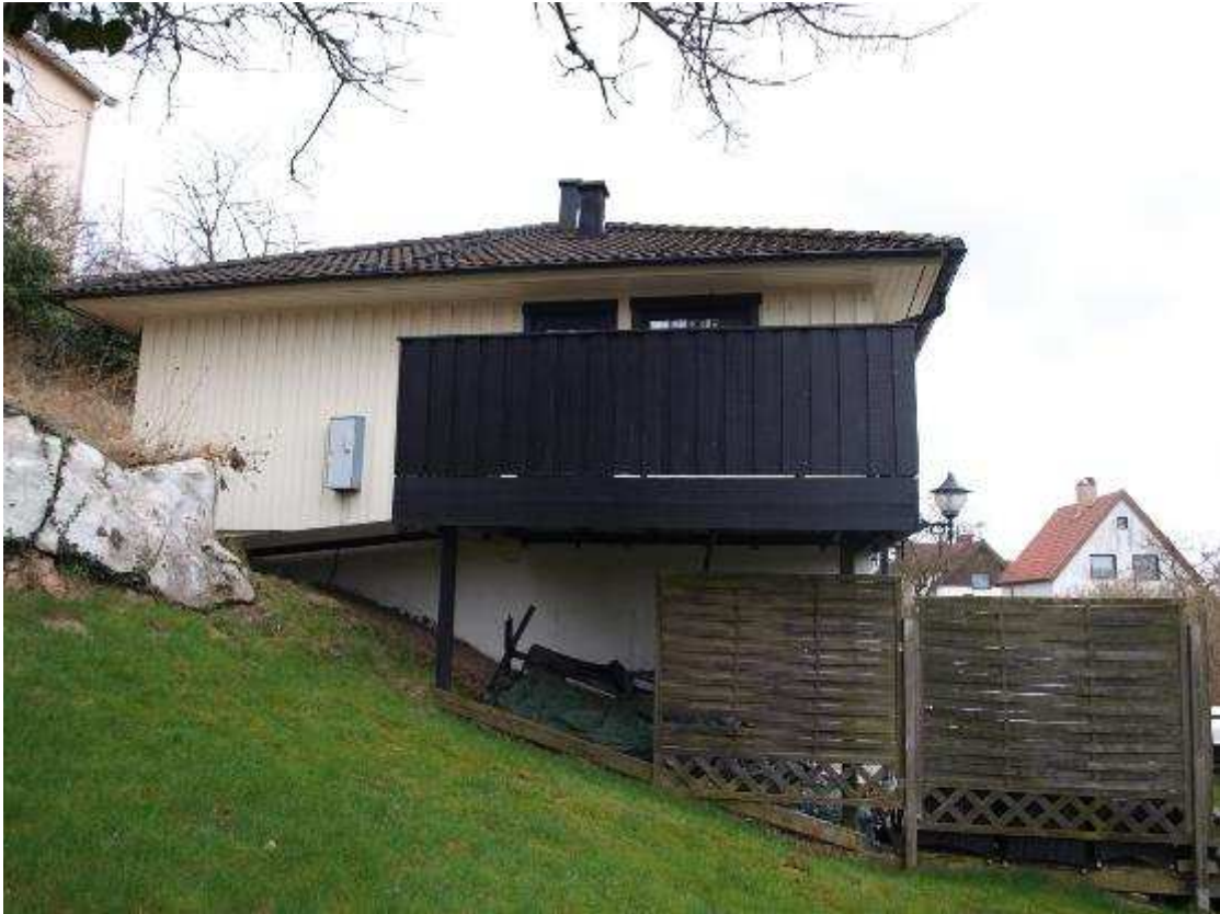
fasad mot norr samt balkong
