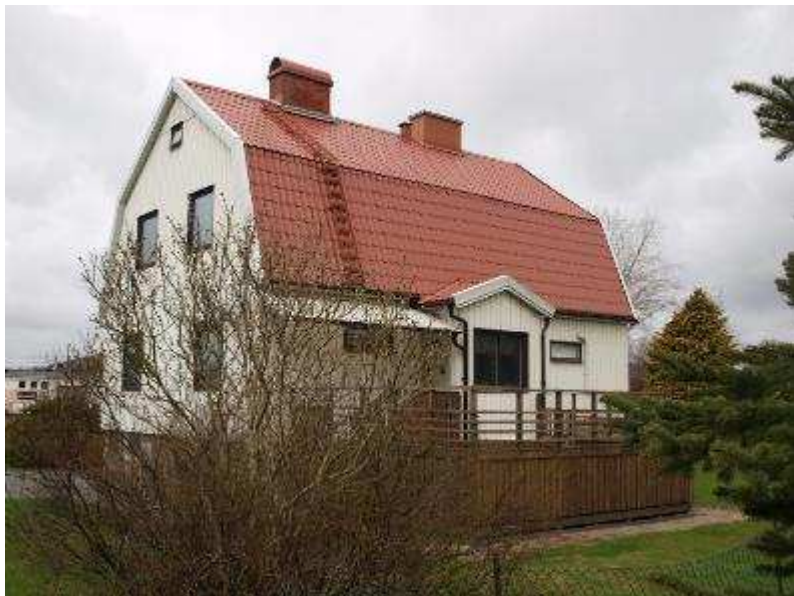
Fastighet mot söder och öster
