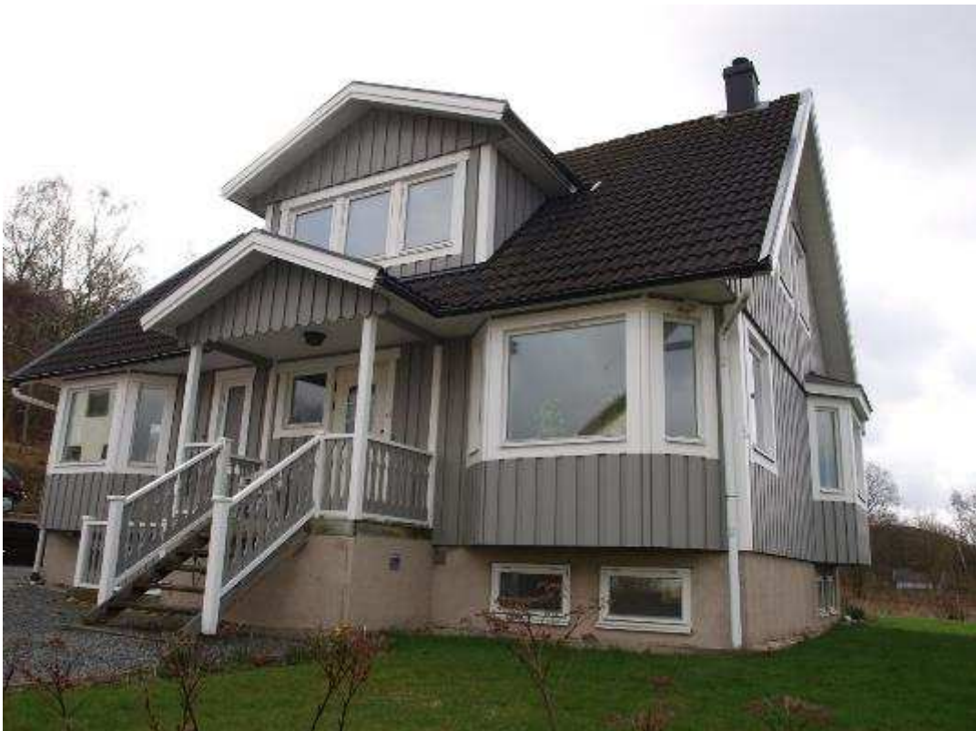
Fasad mot nordväst
