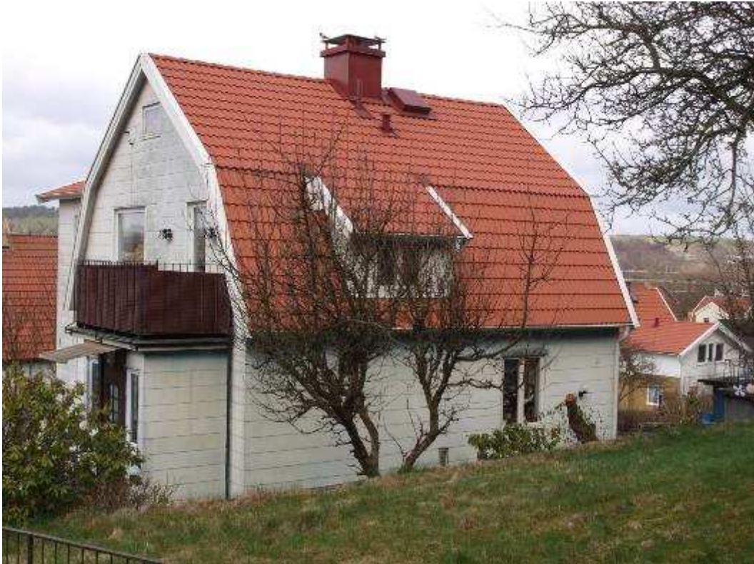
Fasad mot sydost
