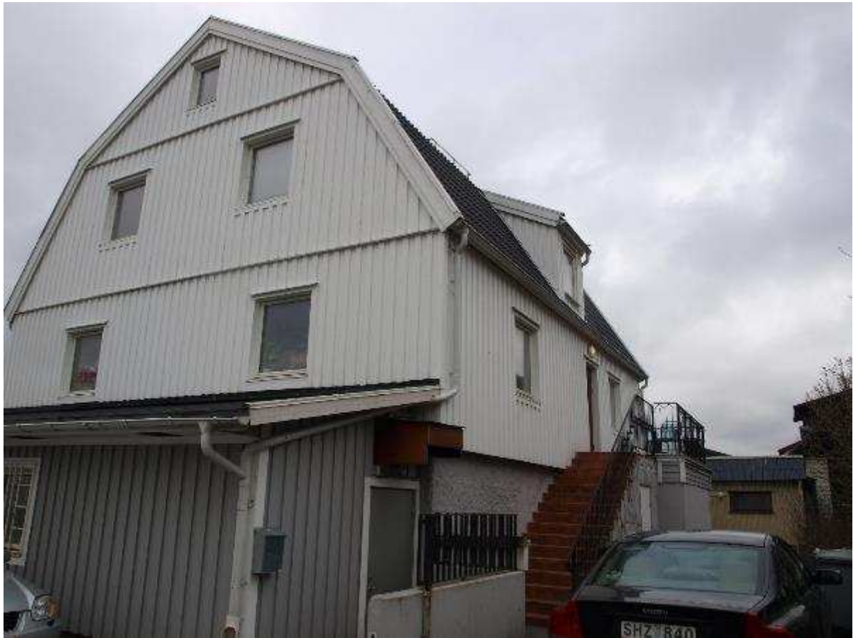
Fasad mot söder och öster
