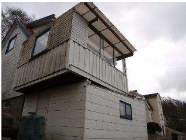
Fasad mot norr och väster
