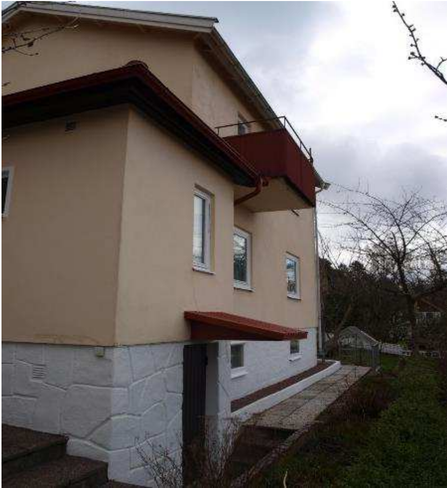
Fasad mot väster. Balkong
