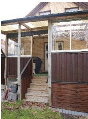
Uteplats mot norrfasad
