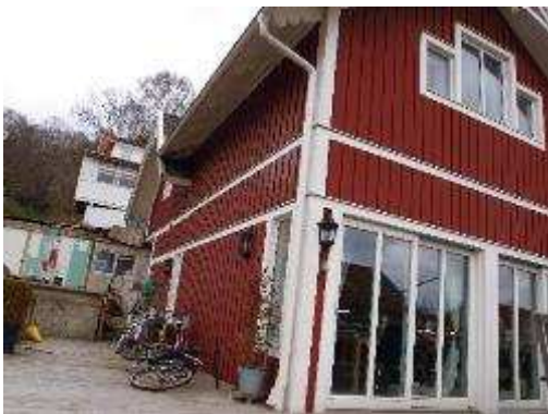
Fasad mot norr och väster
