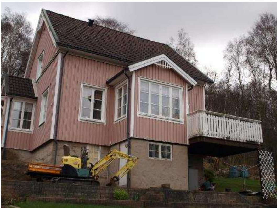
Fasad mot väster. Balkong
