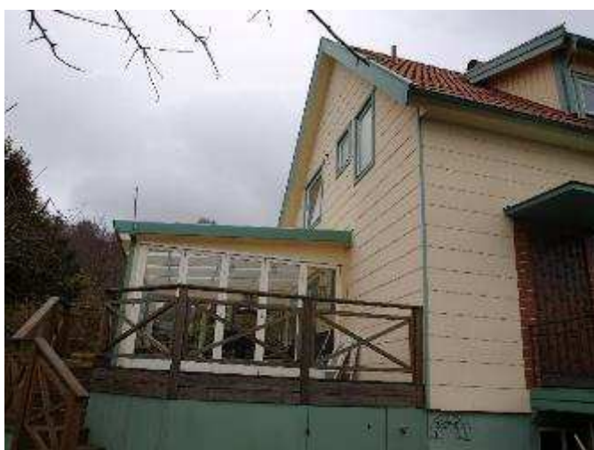
Uteplats mot norrfasad
