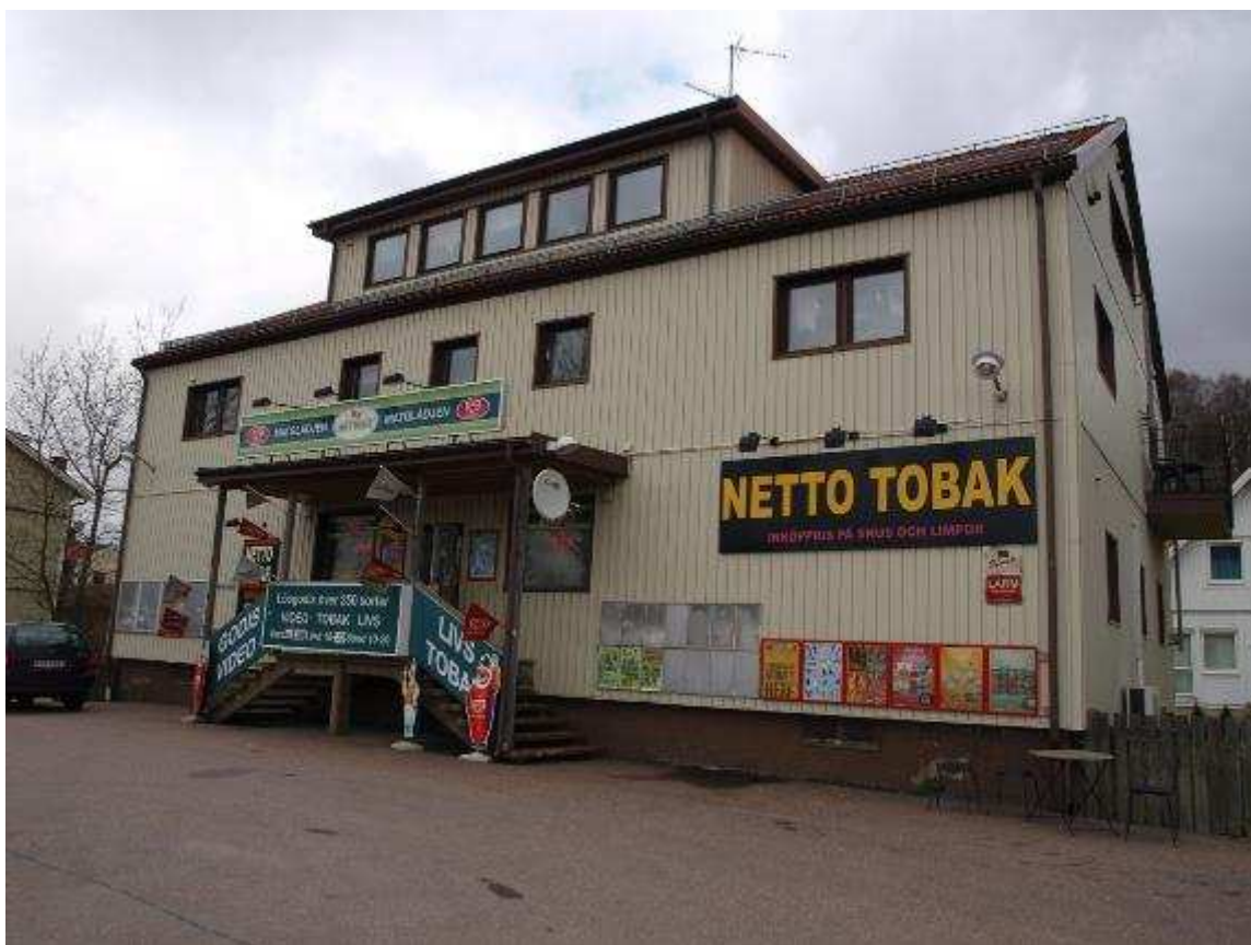
Fasad från väster
