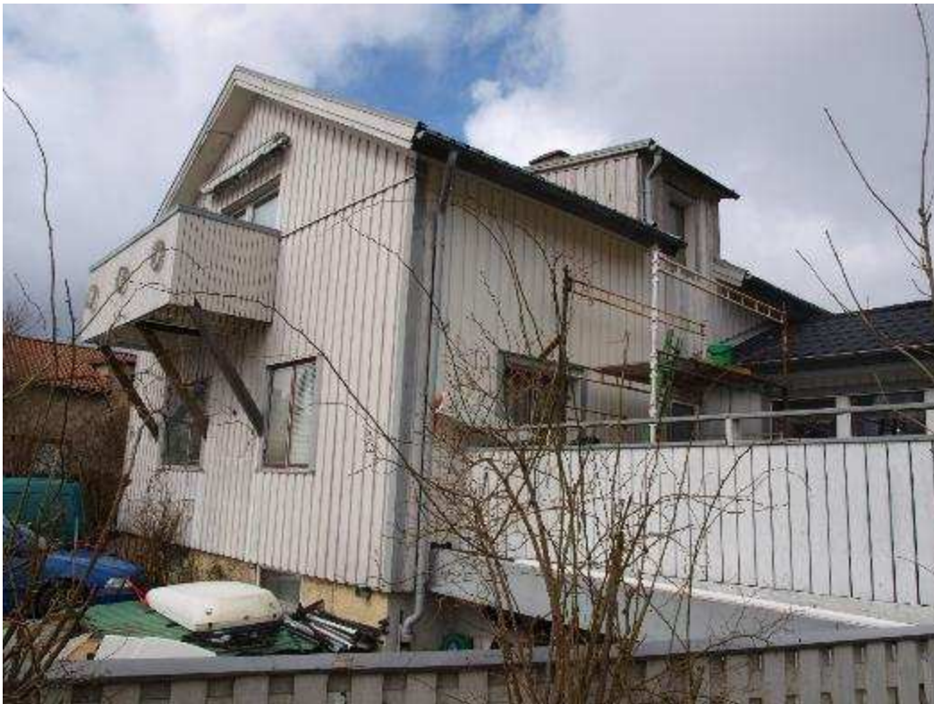
Fasad mot söder och öster
