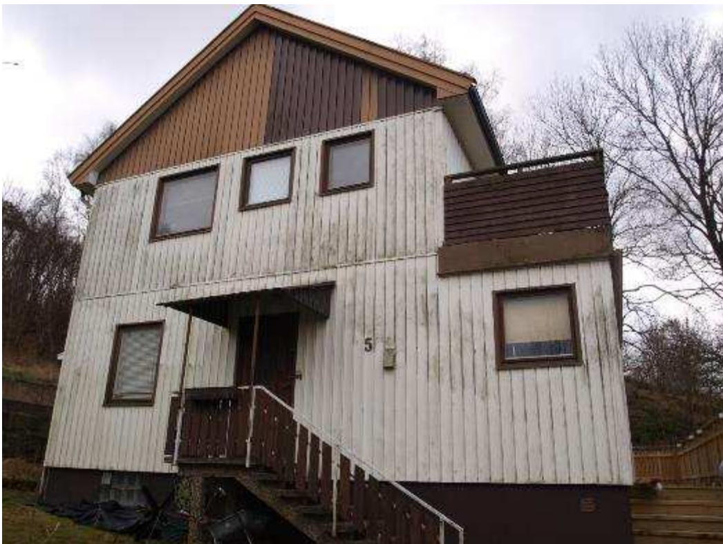
Fasad mot norr. Balkong mot väster
