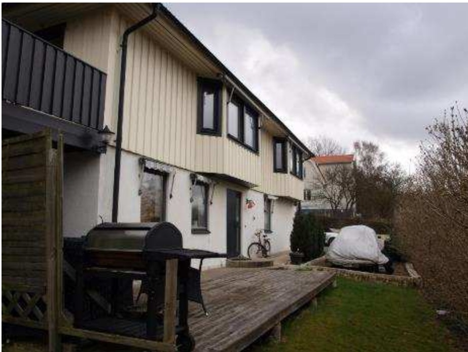
Fasad mot väster samt uteplats
