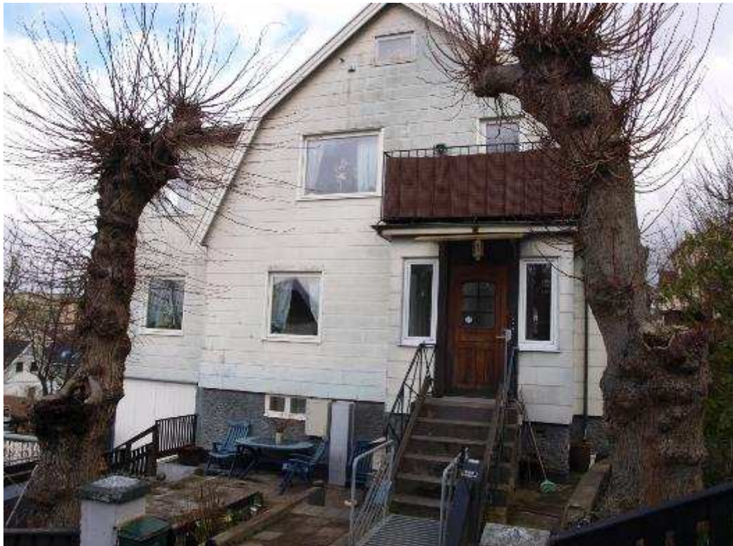
Fasad mot söder. Uteplats och balkong
