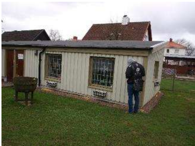
Byggnad där verksamhet bedrivs
