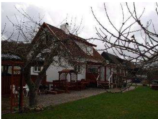
Uteplatser, vy mot sydost
