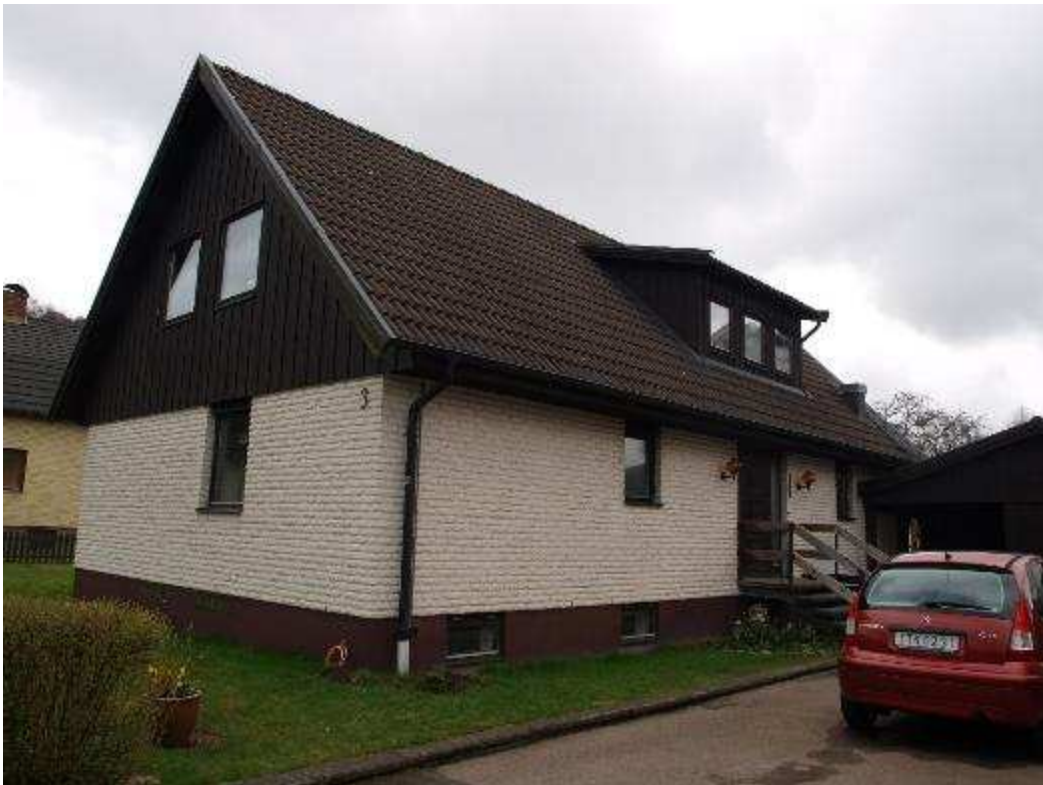
Fasad mot norr och väster
