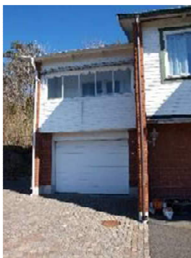
Inglasad balkong mot sydväst
