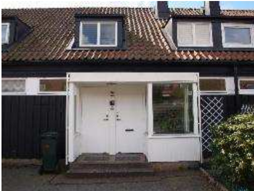
Genrellt utseende entréer, fasad mot nordost
