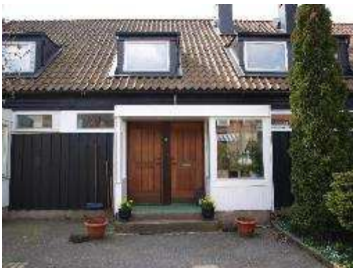
Genrellt utseende entréer, fasad mot nordost
