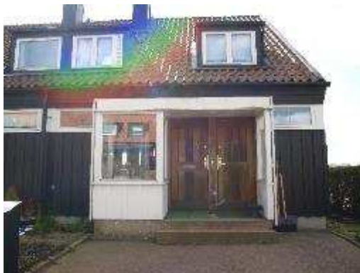
Genrellt utseende entréer, fasad mot nordost
