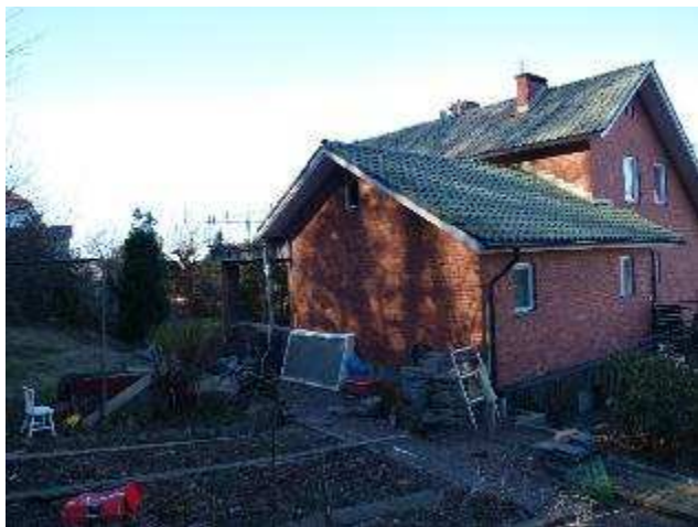
Vy mot sydväst från fastighetens nordöstra hörn
