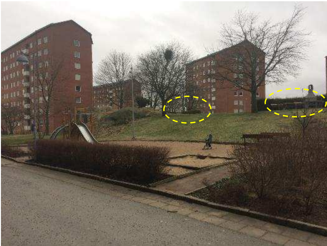
Lekplats med sittgrupp framför västra fasaden. På gräskullen finns ytterligare 2 uteplatser (gulmarkerade).
