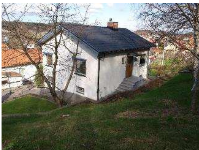
Fasad mot söder och öster
