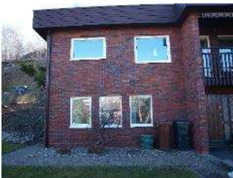
Fasad mot väster
