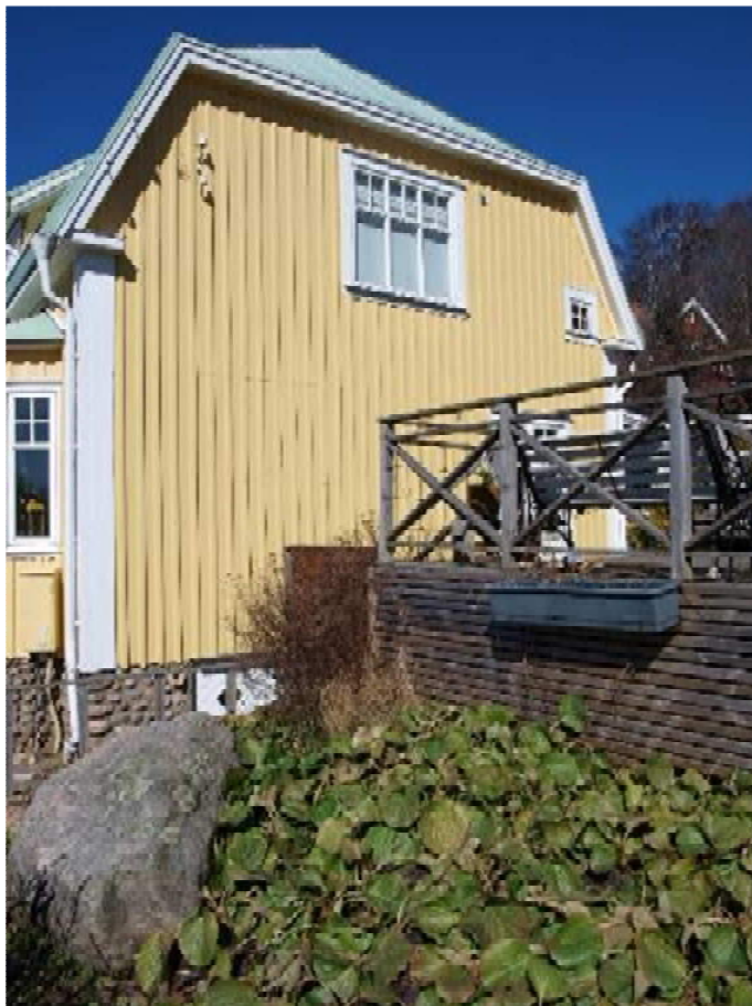
Fasad mot sydost
