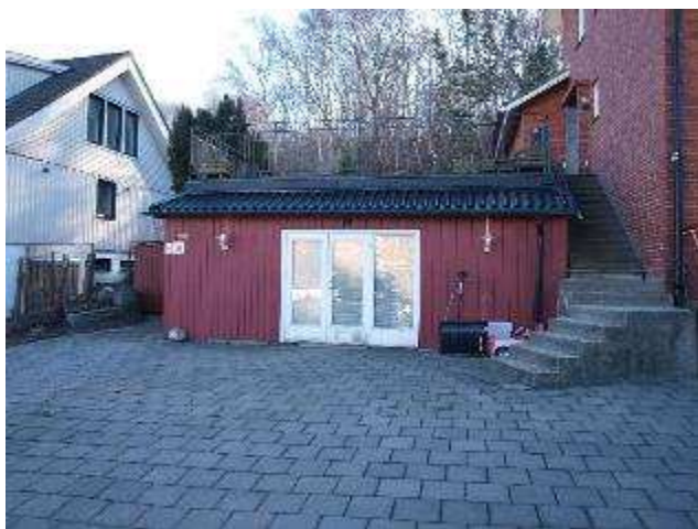
Uteplats ovanpå förrådsbyggnad, intill huvudbyggnads norrfasad
