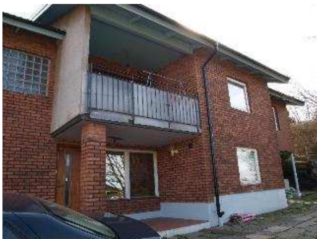
Fasad mot väster
