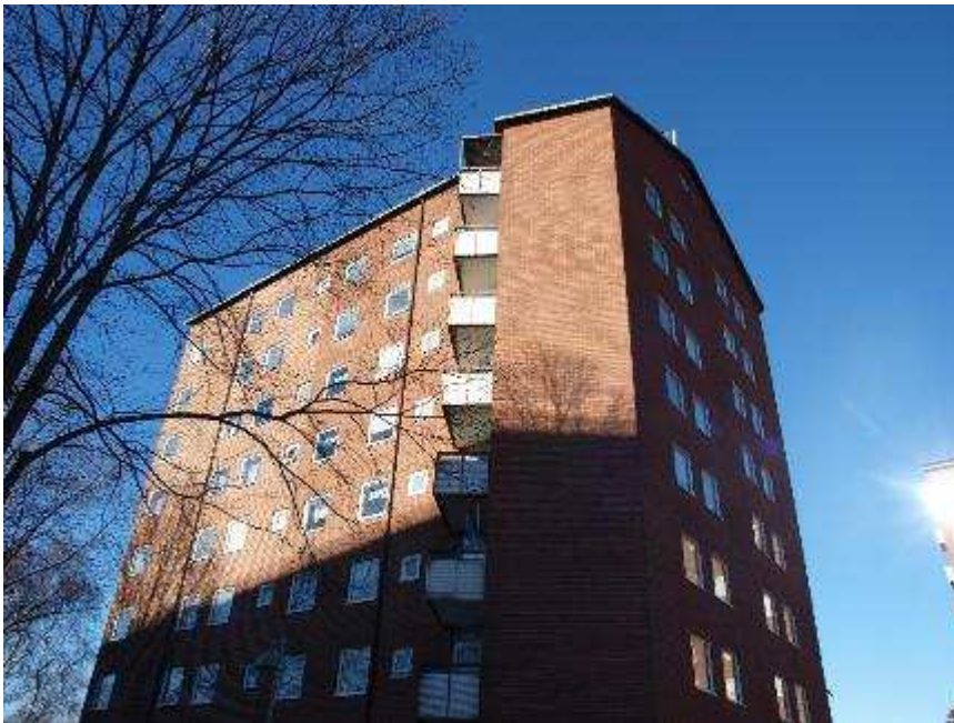
Fasad mot väster och norr
