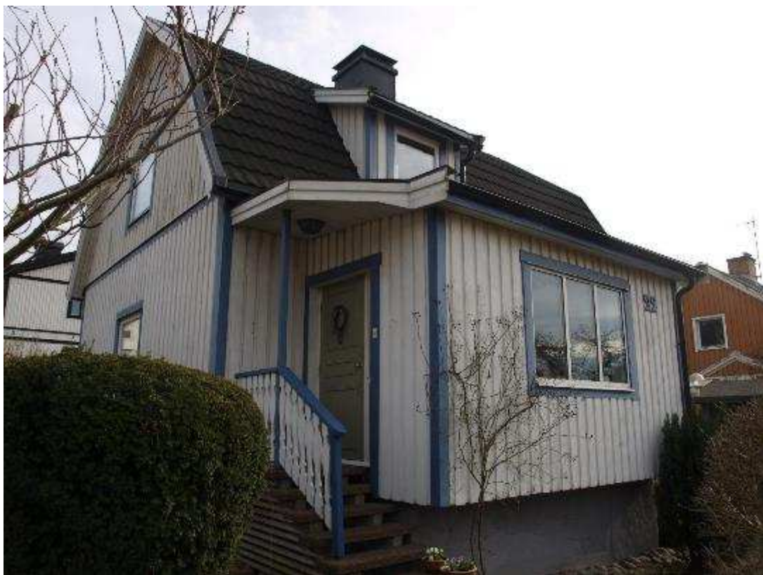
Fasad mot nordost (tv) nordväst (th)
