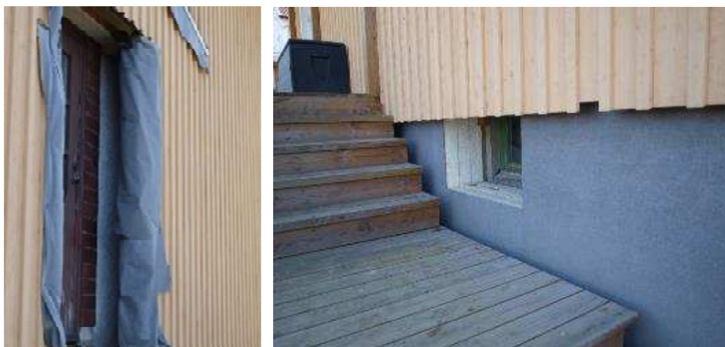
Inblickar i fasadkonstruktionen
