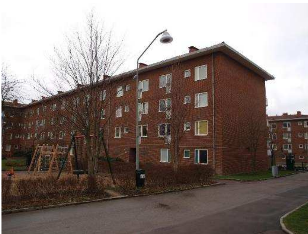
Västra delen av byggnaden mot innergården och lekplats
