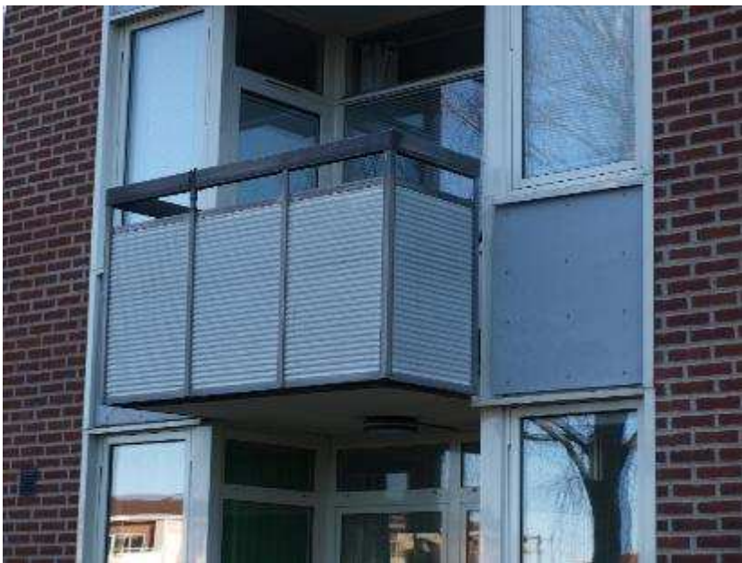
Detalj balkong på söderfasad
