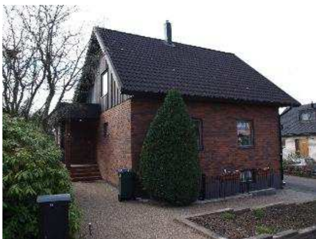
Fasad mot öster med entré och fasad mot norr
