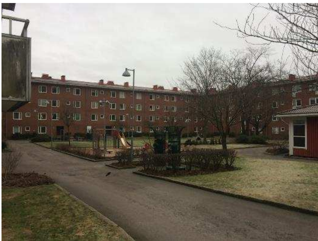
Innergård med lekplats och sittplatser. Bild mot söder.
