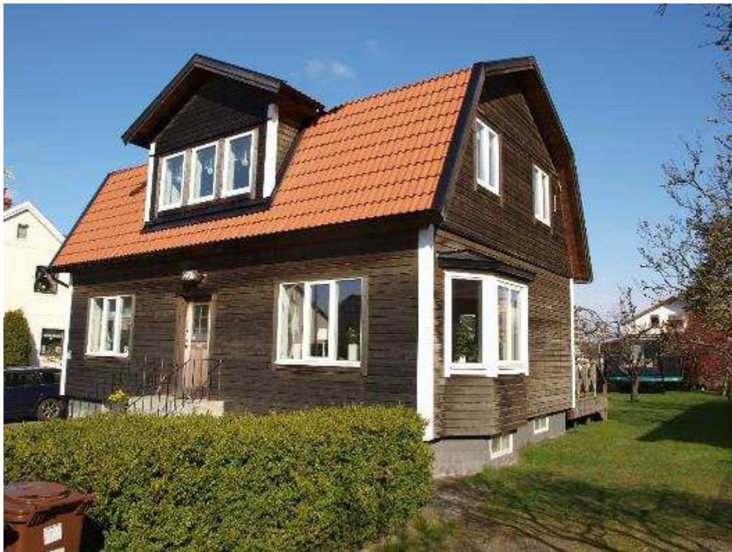
Fasad mot söder och öster
