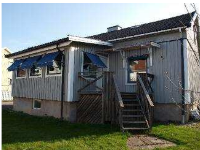
Fasad mot väster
