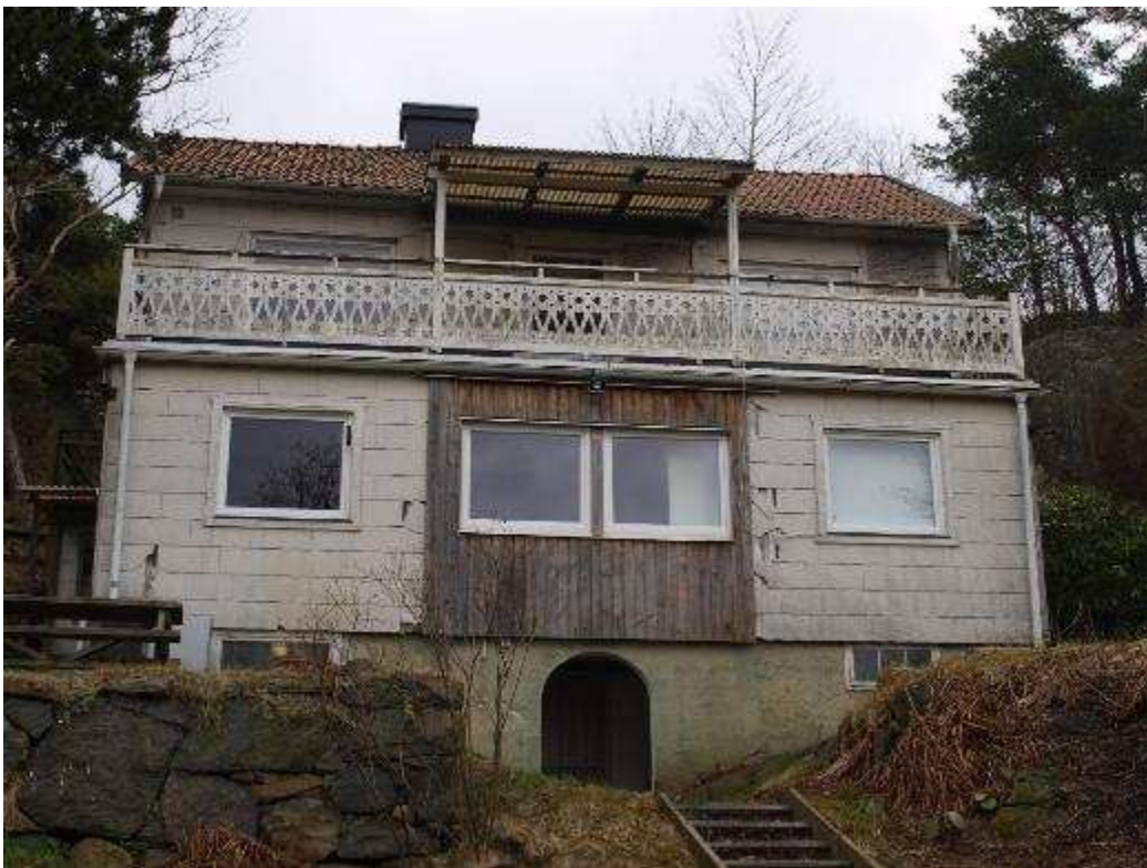
Fasad mot väster
