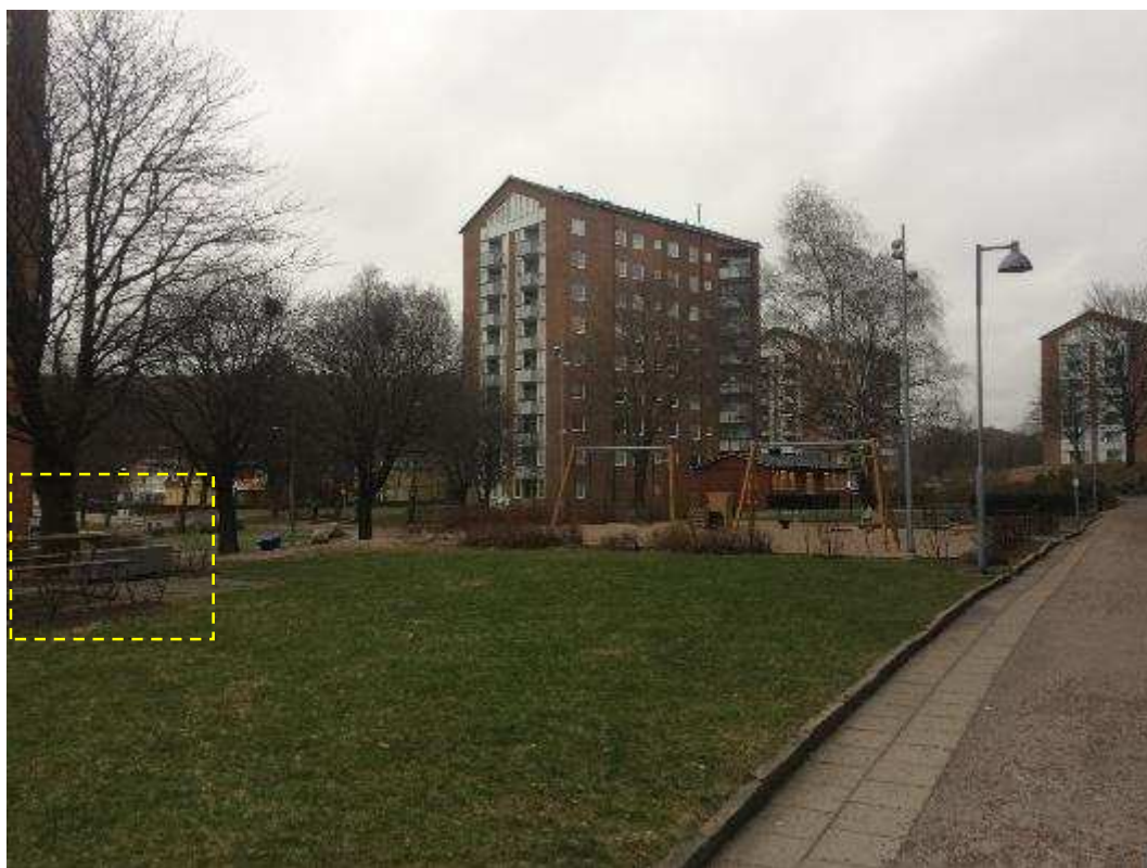
Gemensam uteplats (inom gul markering) och lekplats på västra sidan om fastigheten. Denna uteplats är bullerutsatt (> 55 dBA ekv ljudnivå)
