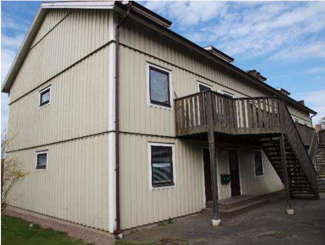
Fasad mot söder och öster
