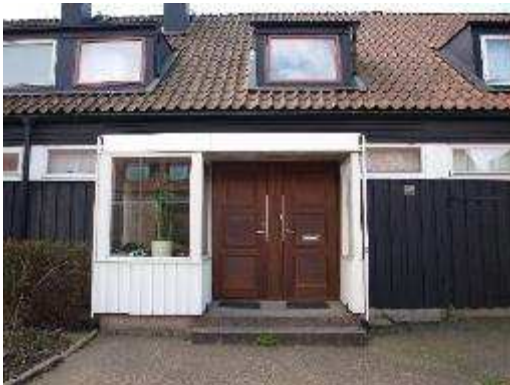
Generellt utseende entréer, fasad mot nordost
