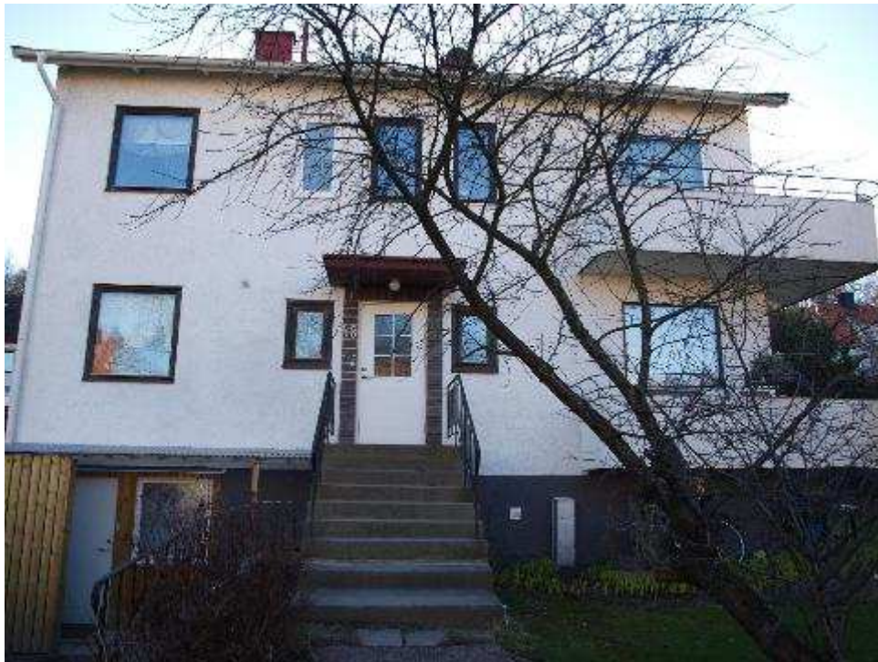
Fasad mot väster
