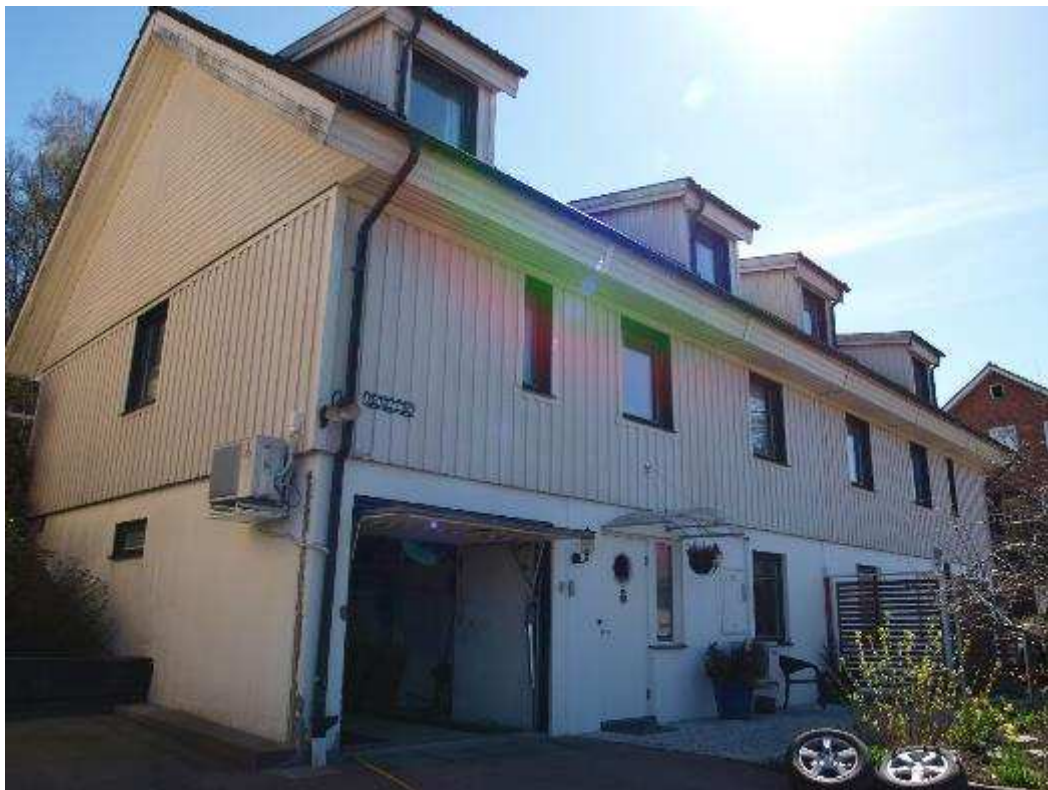
Fasad mot väst, samt norr
