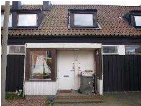
Generellt utseende entréer, fasad mot nordost
