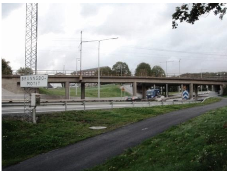
Figur 10 Järnvägsbro för Bohusbanan som korsar Lundbyleden.
