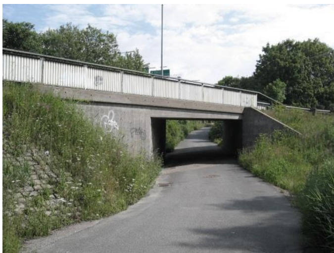
Figur 12 Bro över cykelväg.
