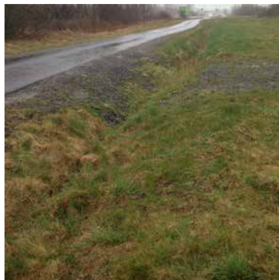
Figur 5.13 Dagvattendike Vrånge intill gång- och cykelväg vid Österleden.
