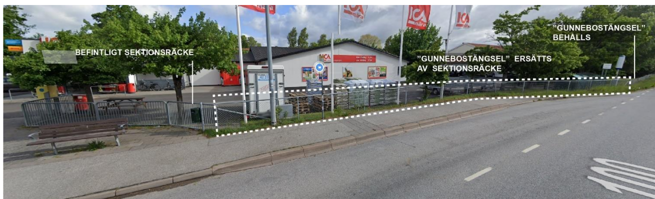
Figur 15. Bild visar befintlig busshållplats med befintliga räcken. Vid busshållplatsen idag finns det räcken av typen "Gunnebstängsel". Dessa avlägsnas och ersätts av nya räcken likt befintliga sektionsräcken (se figur 16 och 17 för förtydligande av sektionsräcken) och ska vara i kulör RAL 7022 enligt Skånetrafikens riktlinjer. Dessa sektionsräcken placeras på ungefär samma plats som befintliga "Gunnebstängsel".
