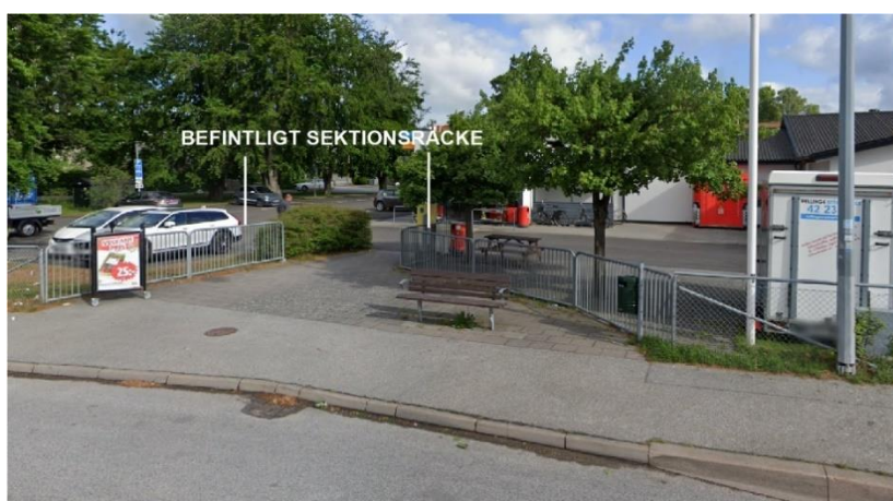
Figur 16. Bild visar befintlig busshållplats med befintliga sektionsräcken. Dessa räcken lackeras i kulör RAL 7022 enligt Skånetrafikens riktlinjer. De målas på plats eller ersätts med ett nytt räcke i denna kulör. Befintlig bänk ersätts med ny enligt Skånetrafikens riktlinjer samt kompletteras med en papperskorg och digital tavla enligt Skånetrafikens riktlinjer.
