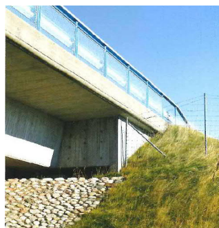
Till vänster Exempel på stensättning under bron och mötet med grässlätten. Källa: En bok om vägarkitektur Vägen, Vägverket.
