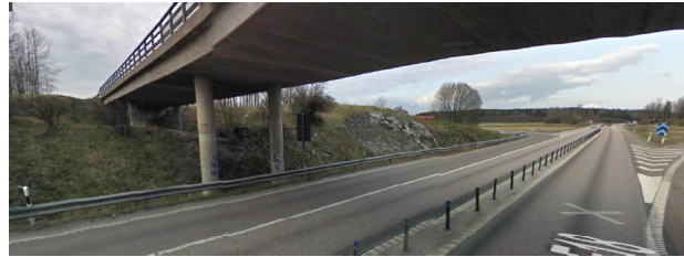
Bild från idag. Under bron läggs kullersten i cementbruk för ett prydligt distinkt uttryck. För ett enhetligt uttryck utformas en likadan stensättning, även på den södra sidan.
