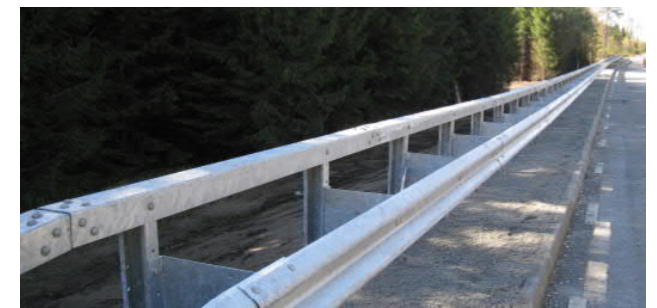
Exempel på högkapacitetsräcke. Förekommer vid broar och vattenskyddsområden (Källa Birsta AB)
