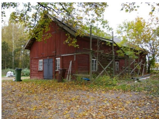
Figur 13 Berga –Svedvi. Bebyggelse invid E18:s norra sida. Äldre ekonomibyggnader, timmer.
