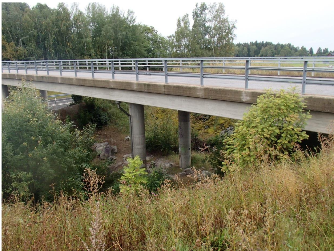
Bro förberedd för breddning vid trafikplats Morgendal
