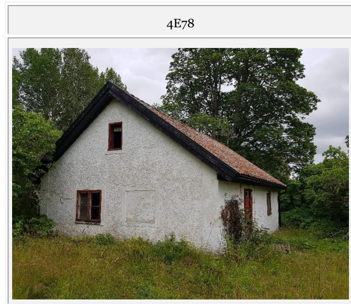
Figur 7-13 Bostadsbyggnader som är bullerberörda vid Lilla Hällan, Gammelsta
