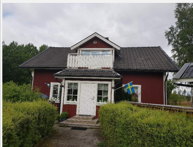
Figur 7-16 Bostadsbyggnader som är bullerberörda vid Långkärr, Ålberga
