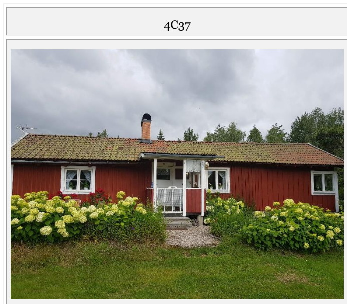
Figur 7-18 Bostadsbyggnader som är bullerberörda vid Kila Källtorp, Ålberga
