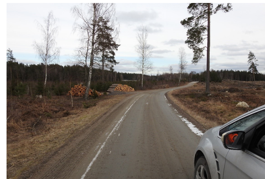
Figur 7-58. Vy i riktning söder mot läge för ny vägbro nära Önskehem. Foto: KMV forum.
