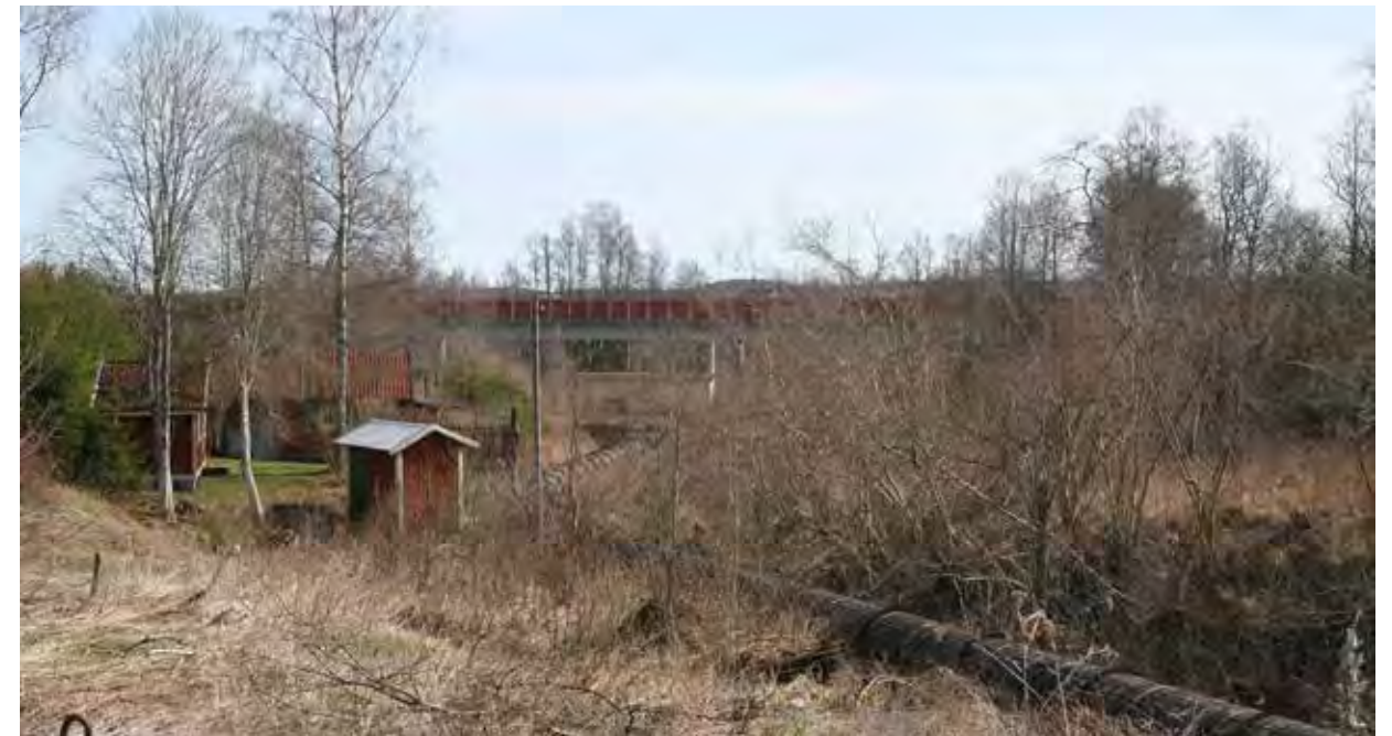
Vy 2. Vy mot söder (ungefär från samma läge som vy 1) som visar vattenledningen. Kraftverket och väg E4 syns i bakgrunden.
