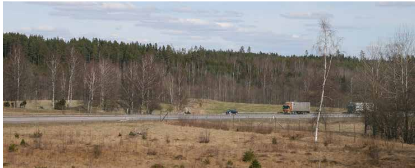
Vy 3. Gamla vägens passage genom dalgången sett från södra sidan.
