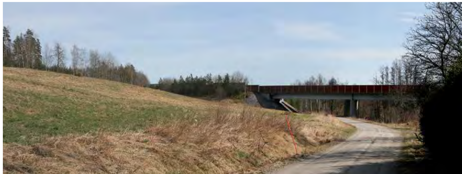
Vy 3. Vy mot söder med väg E4:ans passage över Ålbergaåns dalgång.
