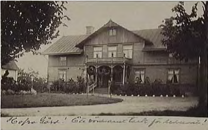
Huvudbyggnaden vid Hovra på ett vykort från 1904. Källa: Sörmlands museum
