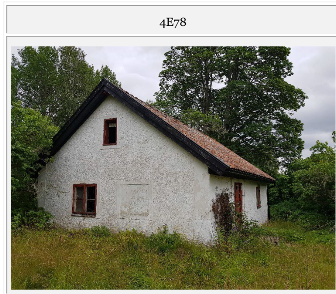
Figur 7-11 Bostadsbyggnader som är bullerberörda vid Lilla Hällan, Gammelsta.
