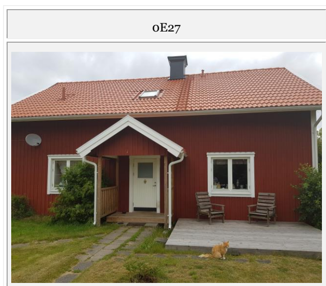
Figur 7-31 Byggnader som är bullerberörda vid Hjälma Stockholmstorp 1.
