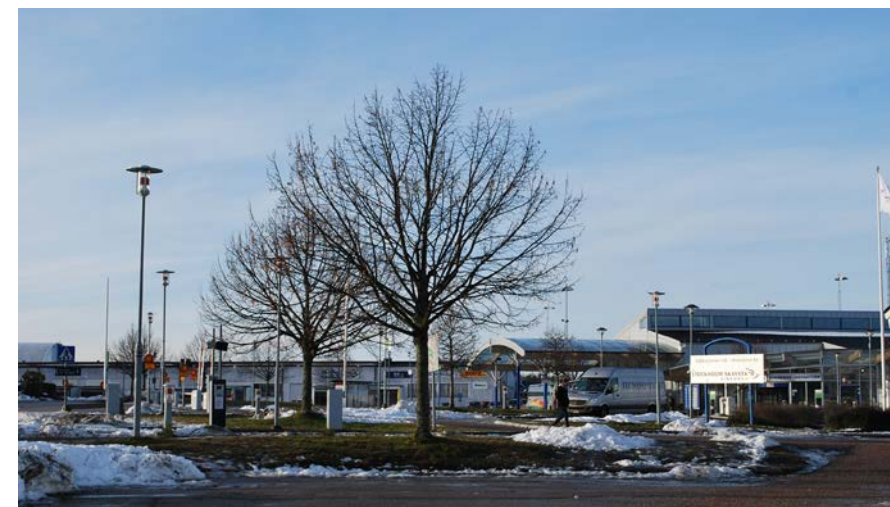
Figur 67. Entré Skavsta flygplats.
