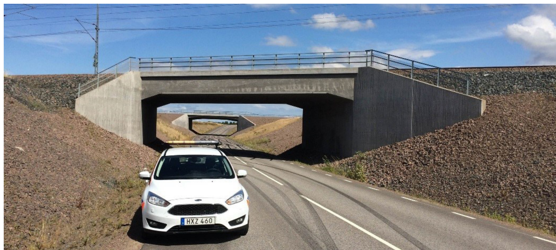
Figur 28. Exempel på järnvägsbro över väg i form av en plattrambro med vingmurar.
