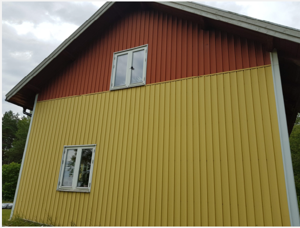
Figur 7-35 Byggnad som är bullerberörd vid Stigtomta Listorp 1.
