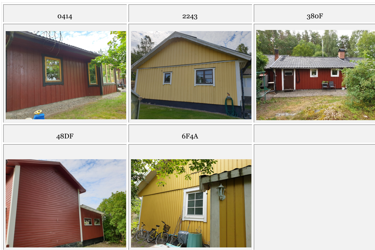
Figur 7-23 Byggnader som är bullerberörda vid Bullersta.
