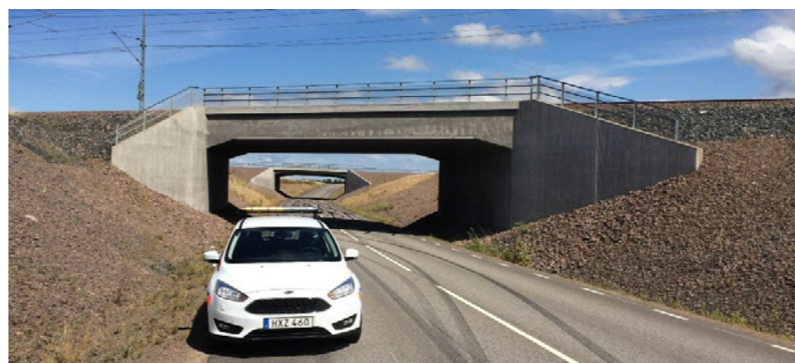
Figur 23. Exempel på järnvägsbro över väg i form av en plattrambro med vingmurar.
