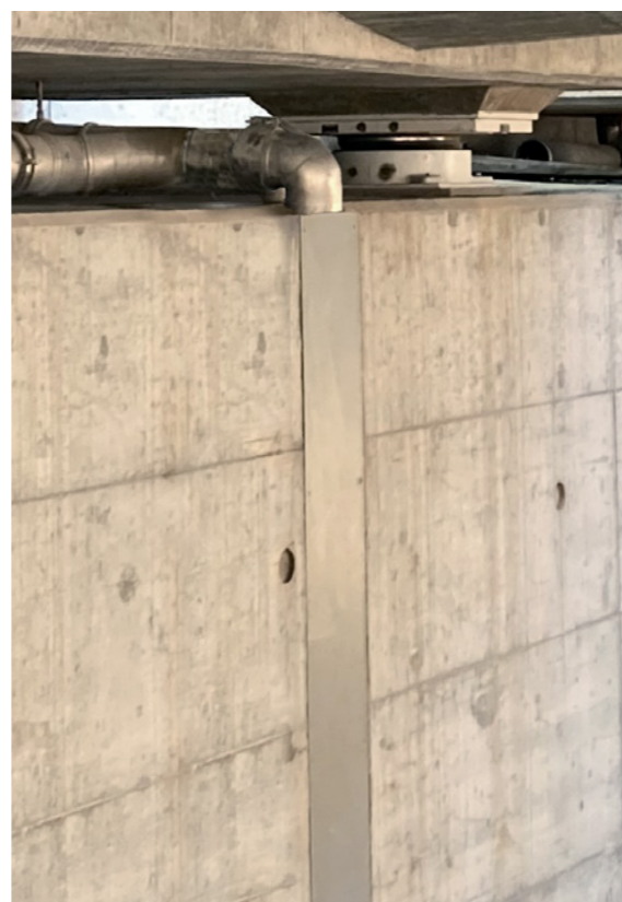
Figur 180. stuprör döljs av metallplatta för att bibehålla brostödet obrutna linjer.
