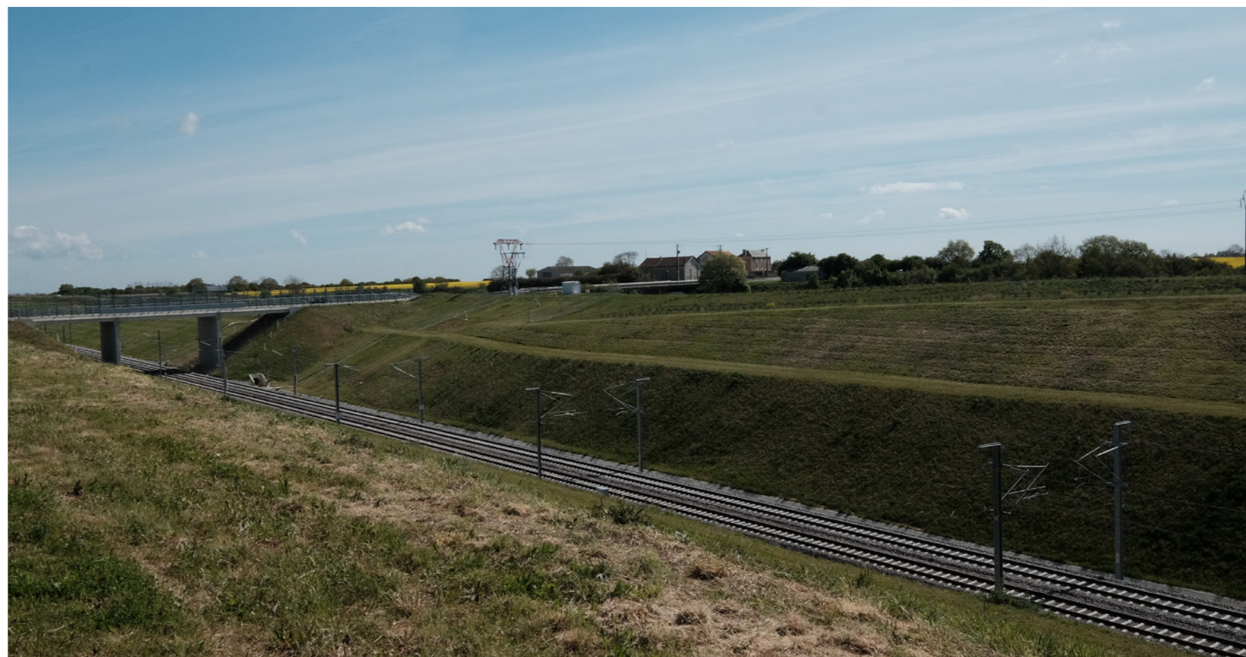
Figur 153. Exempel på slänt med medvetet vegetationsval som bidrar till en landskapsanpassad järnvägsanläggning.
