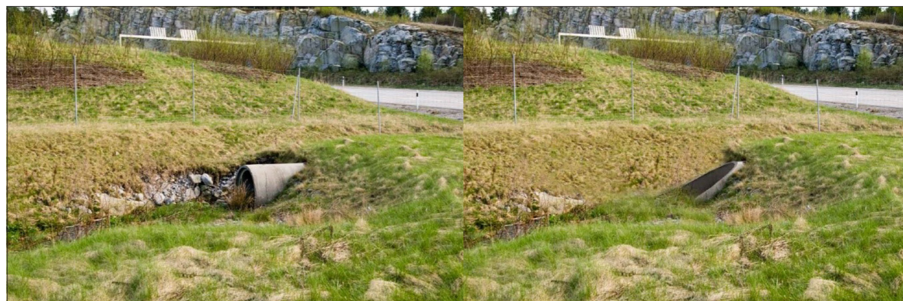
Figur 81. Trumma med rak respektive snedskuren öppning (Trafikverket, 2015).
