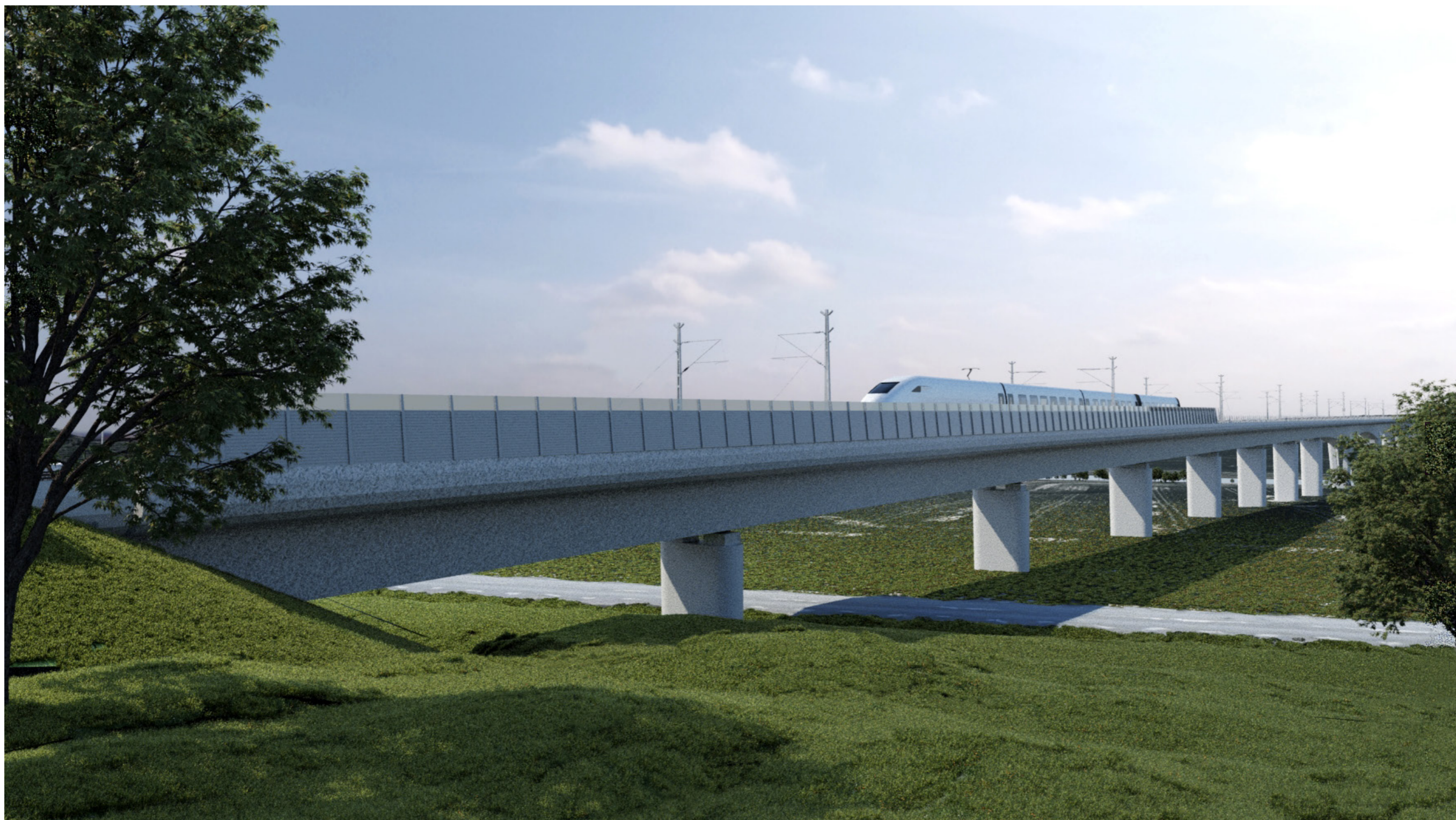
Figur 187. Illustration över Nyköpingsåns dalgång sett från Bönsta. Bullerskyddsskärmens utformning kallar inte på uppmärksamhet, utan smälter väl in med landskapsbron.
