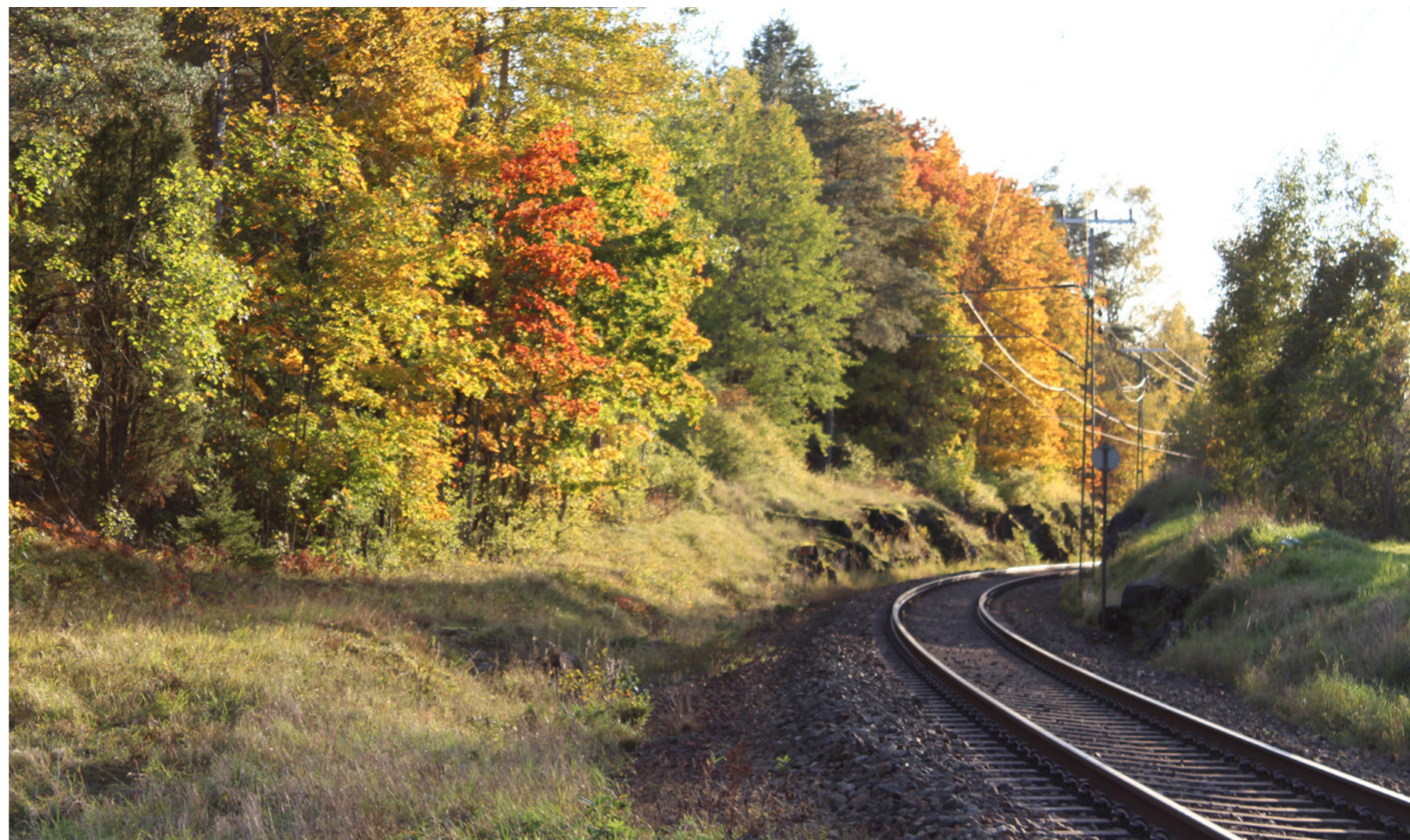
Figur 50. Fotot illustrerar ett exempel en järnväg som går genom en liten skärning. Storlek och djup på skärningarna inom Ostlänken är av mycket varierande grad, med vissa skärningar på uppemot 20 meters djup.
