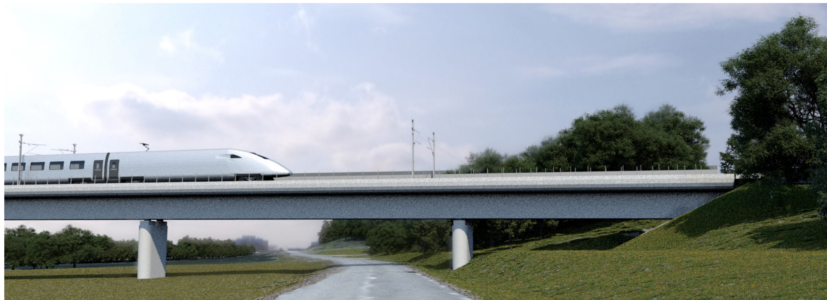
Figur 186. Landskapsbron sedd från väg 53 söderifrån med Bönsta bakom höjdryggen till höger i bild. Söderifrån är bullerskyddsskärmen knappt märkbar då den placeras på den norra sidan av bron.
