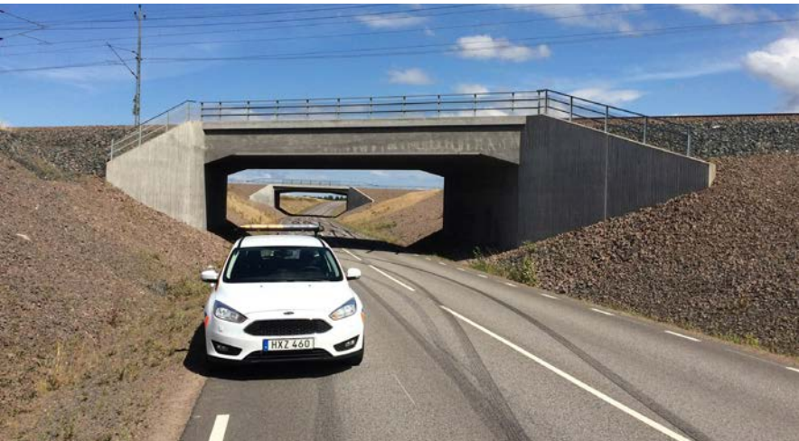
Figur 2-9. Exempel på järnvägsbro över väg i form av en plattrambro med vingmurar.
