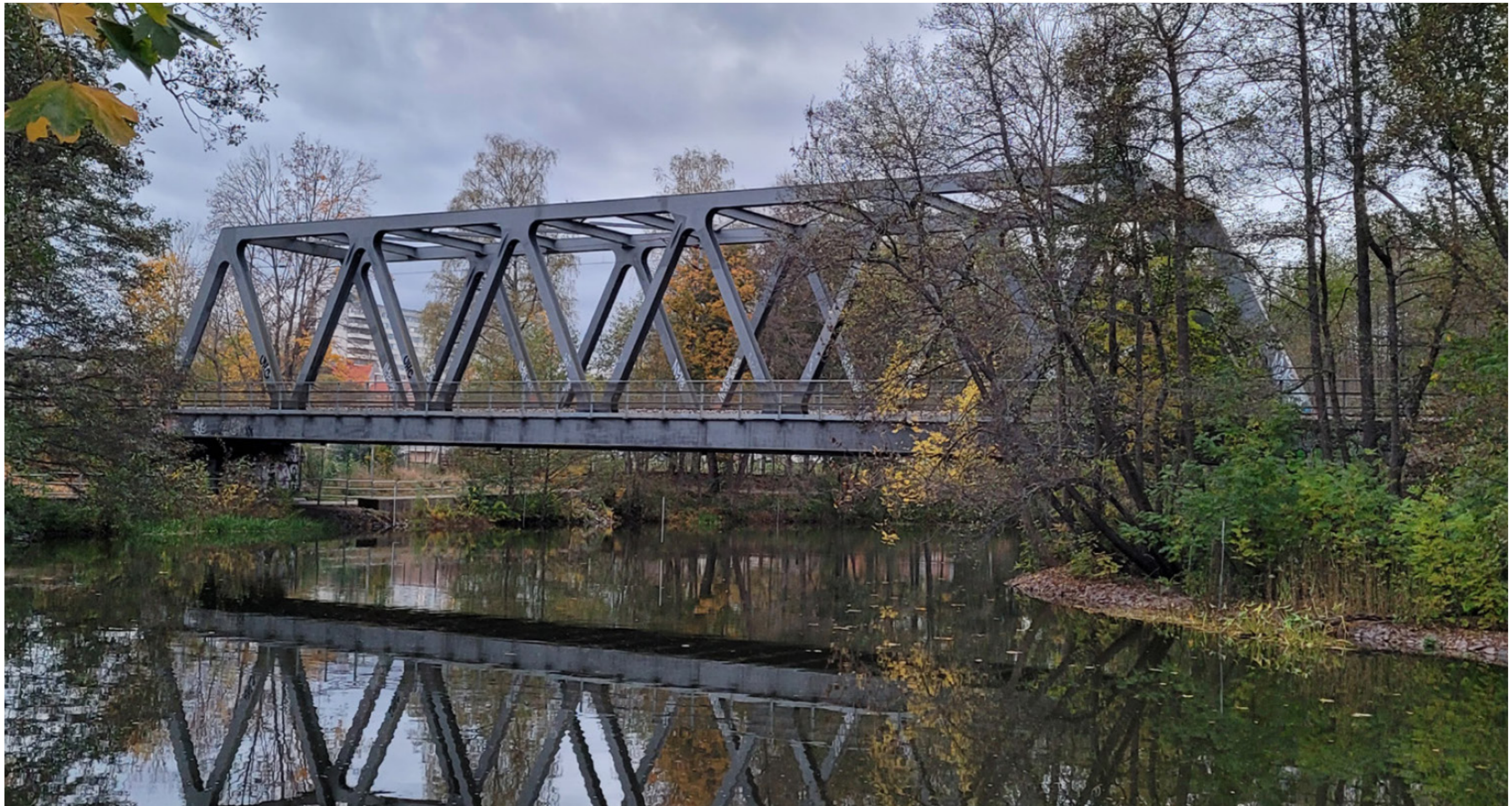
Figur 45. Järnvägens passage av Nyköpingsån på befintlig bro.
