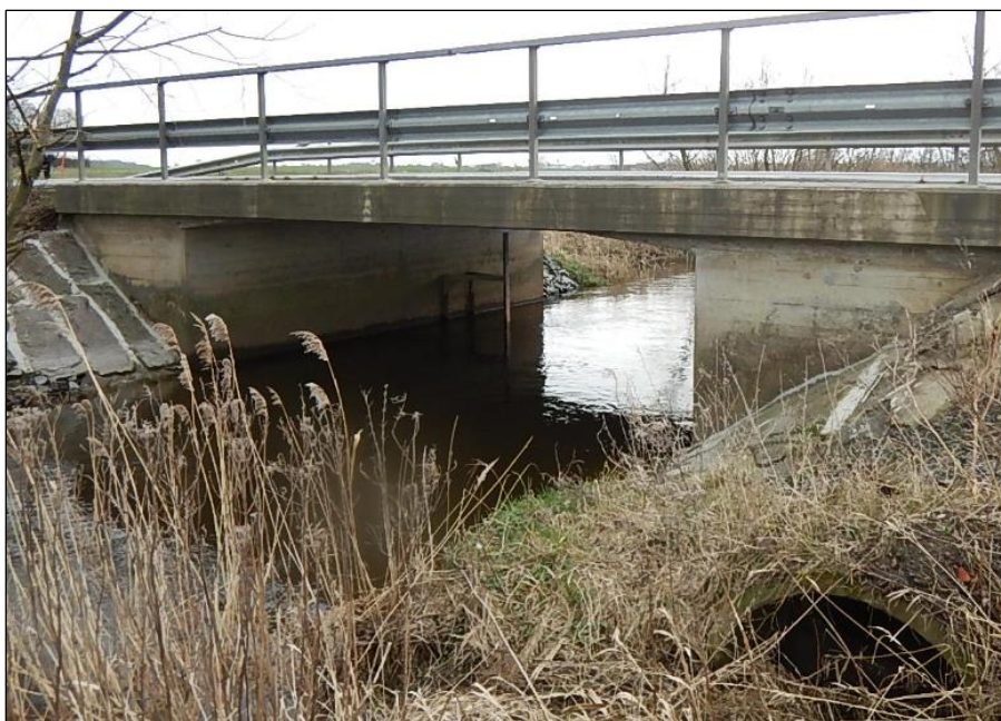
Figur 7. Foto av befintlig vägbro över Vinne å. I det nedre högra hörnet syns ingången till ett av betongrören. Betongröret går hela vägen till andra sidan bron bakom rambenet och det finns ett likadant betongrör vid det andra landfästet.
