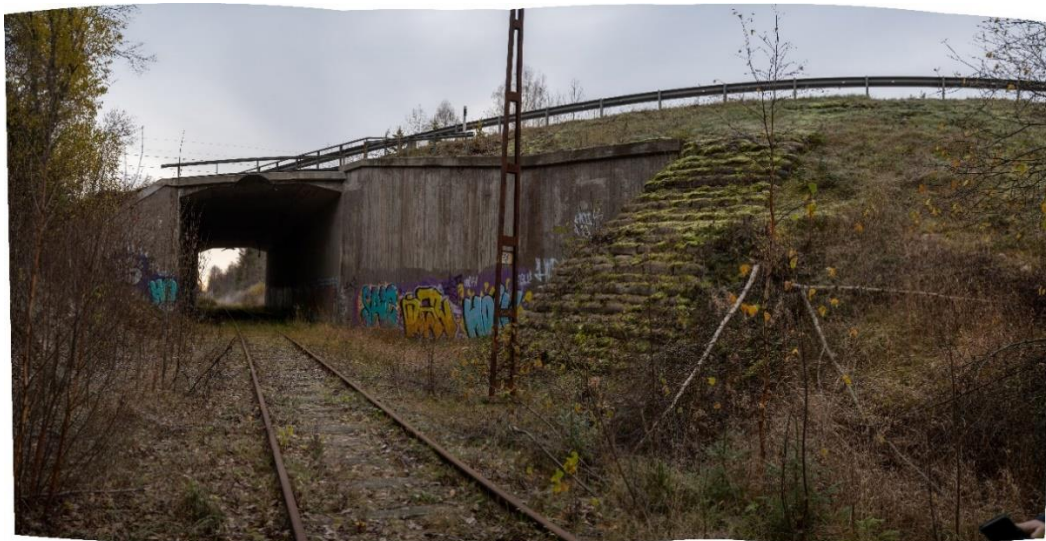
Figur 4.5 - Bro 21-211-1 som är en bro över järnvägen Dellenbanan. Foto mot sydost.
