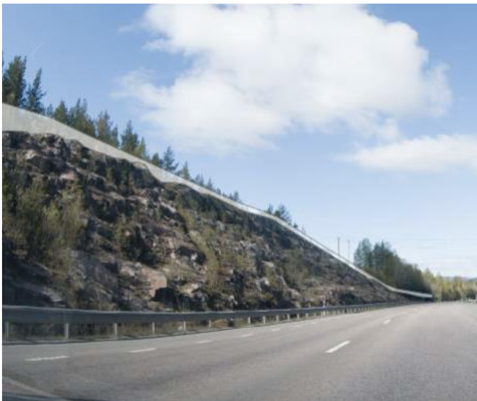
Figur 5.8 - Skiss som föreställer viltstängslets placering vid en bergsskärning. Stängslet har en mjuk linjeföring och byter riktning tidigt för att motverka en ojämn horisontell dragning. Hänsyn tas också till aspekten att stängslet ska kunna anläggas och underhållas på ett bra vis vad gäller utrymme på insidan mot vägen.
