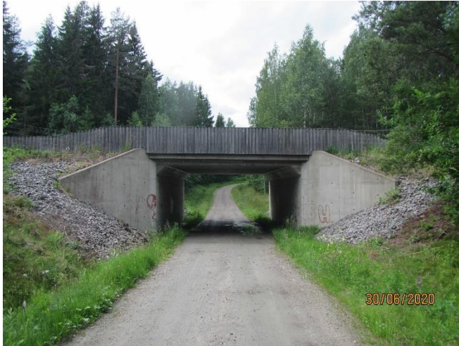
Figur 21 Befintlig bro, E4 över Fäbovägen. Fotografi Trafikverket (Batman).
