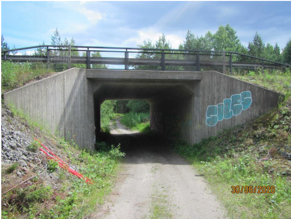
Figur 12 Befintlig vägbro över Bostigen, foto Trafikverket (Batman).
