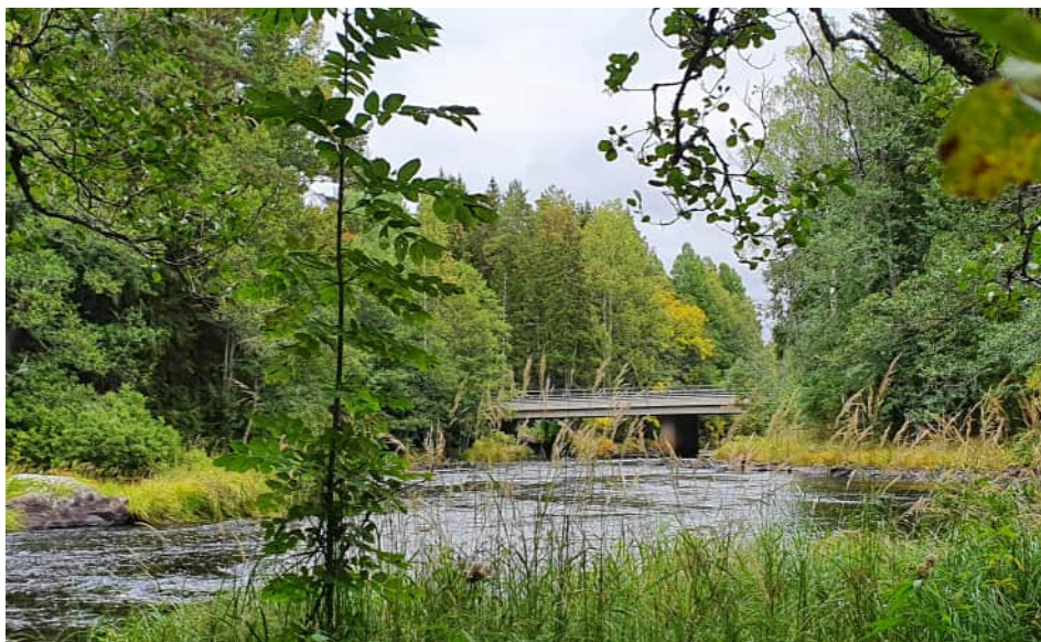
Bild 24. Befintlig E4-bro över Testeboån vy från väster.
