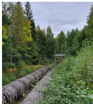
Bild 29. Trätuberna sett mot E4 bron.
