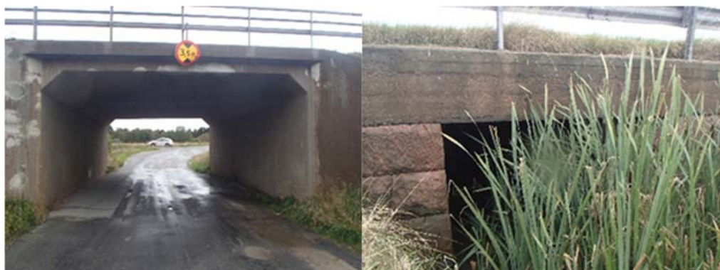
Figur 4.6.4:2 Vänster: Befintlig bro över enskild väg, höger: Bro över bäck vid Fötene.
