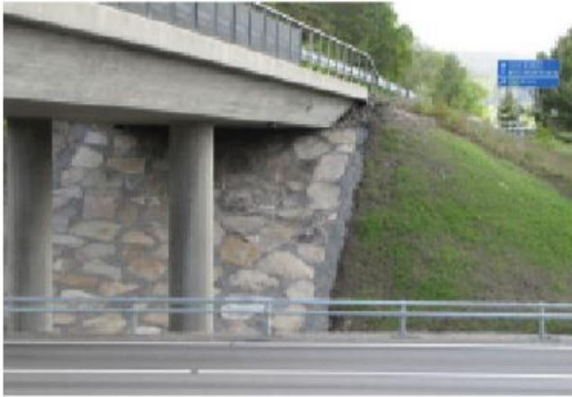
Figur 4.5:1 Ytor under broar som hamnar i regnskugga ska kläs med sprängsten i grus. Brokoner besås med gräs.
