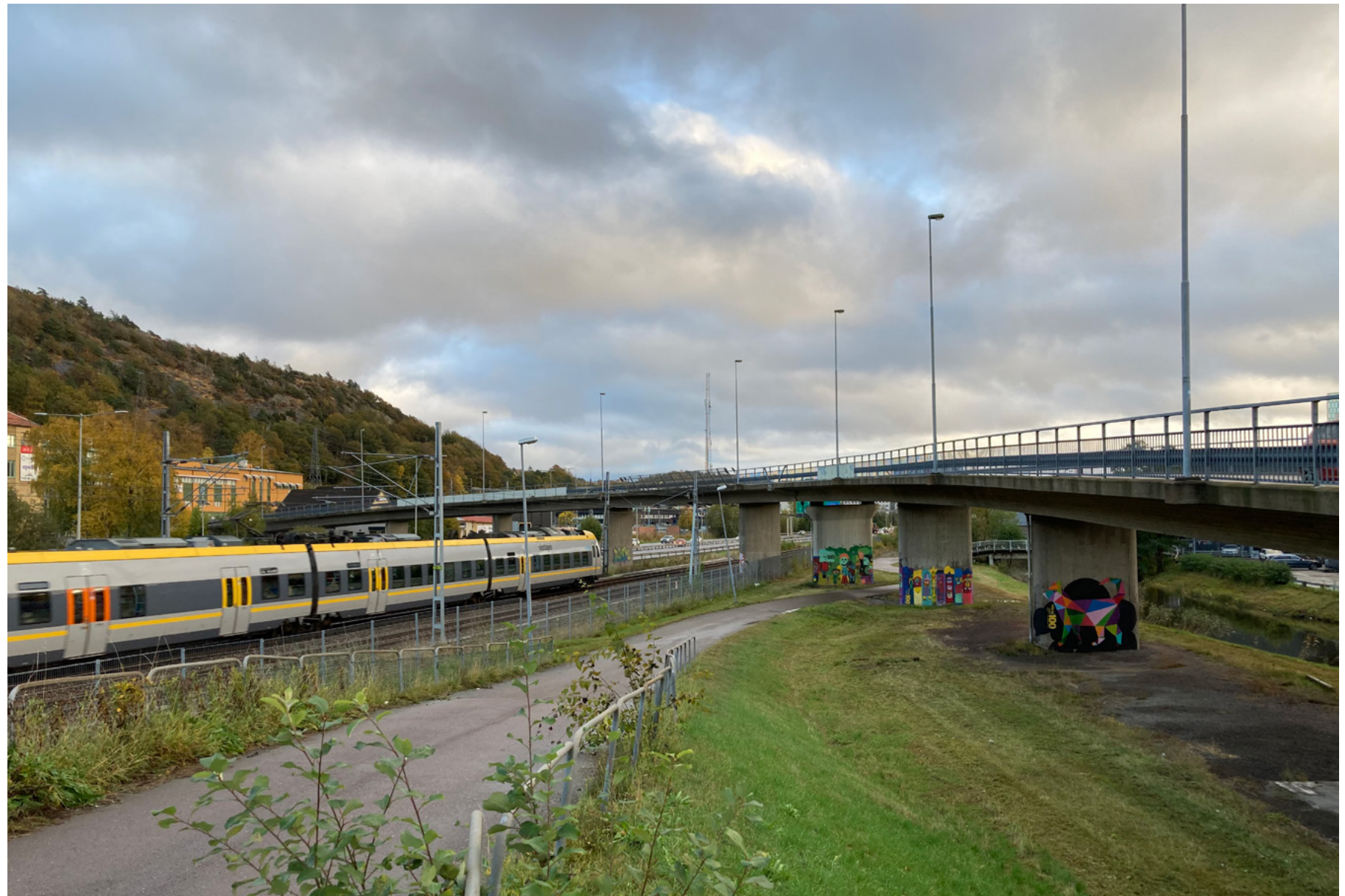
Figur 42: Flöjelbergsbron. Bild från platsbesök.
