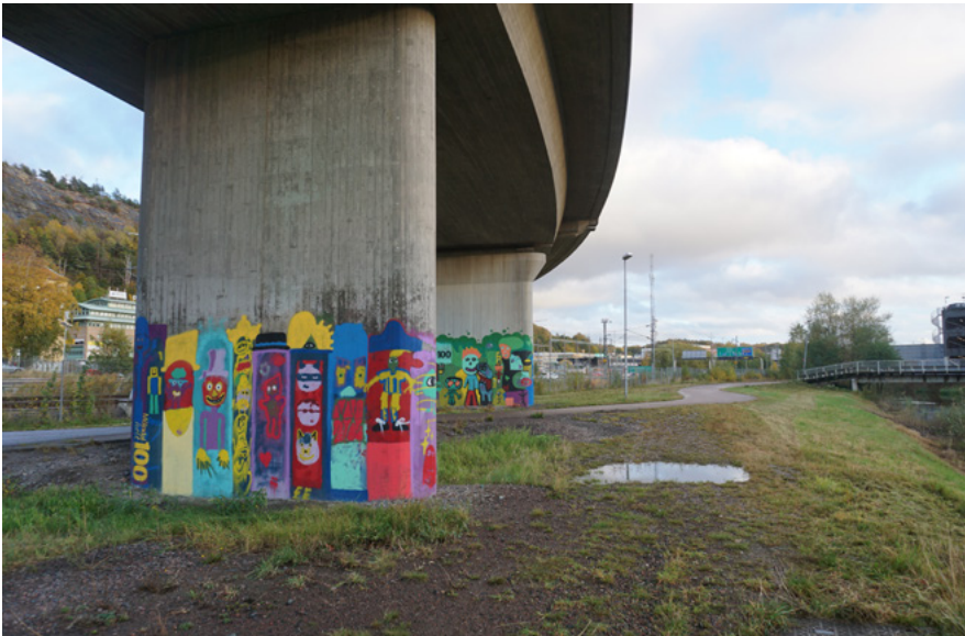
Figur 45: Brostöd under Flöjelbergsbron. Bild från platsbesök.
