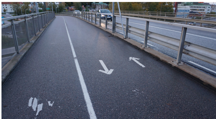
Figur 48: Gång- och cykelbana vid Lackarebäcksmotet. Bild från platsbesök.
