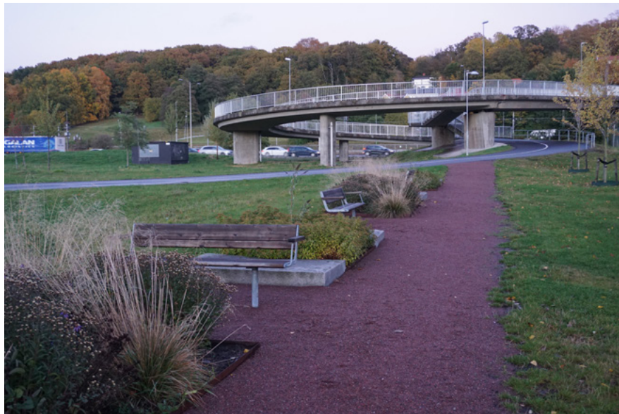
Figur 51: Ekekullsbron västra brofäste, i anslutning till en fickpark. Bild från platsbesök.
