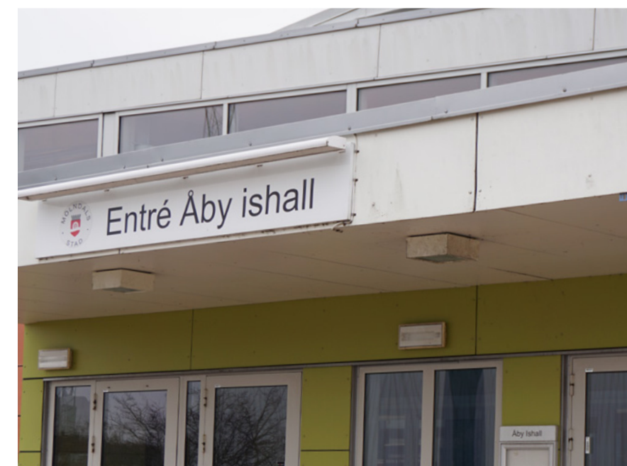
Figur 28: Entré till Åby Ishall. Bild från platsbesök.
