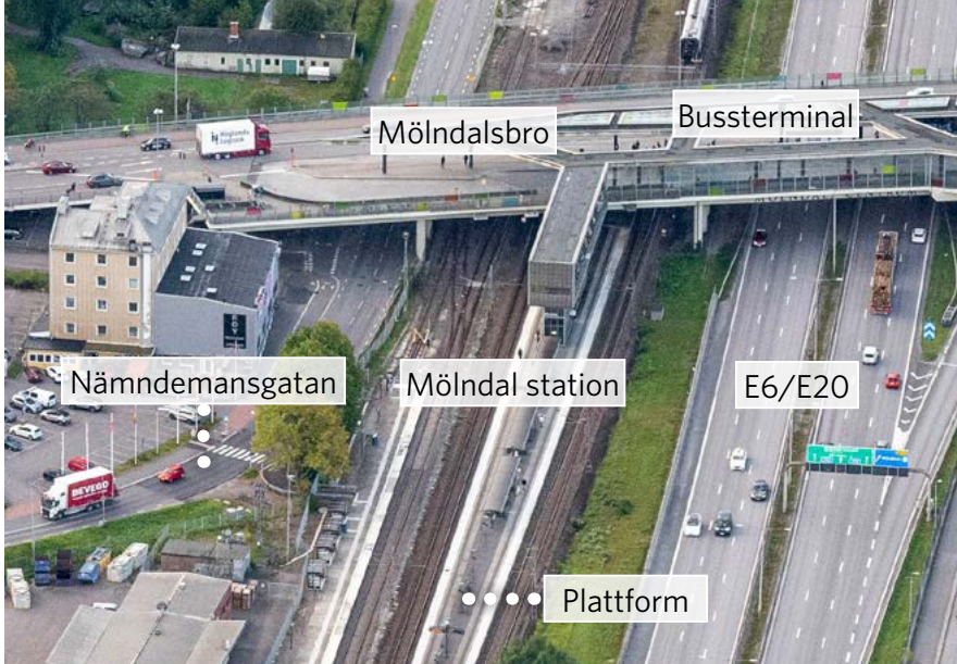
Figur 3.4.1.2. Befintlig Mölndal station. Foto från 2024.
