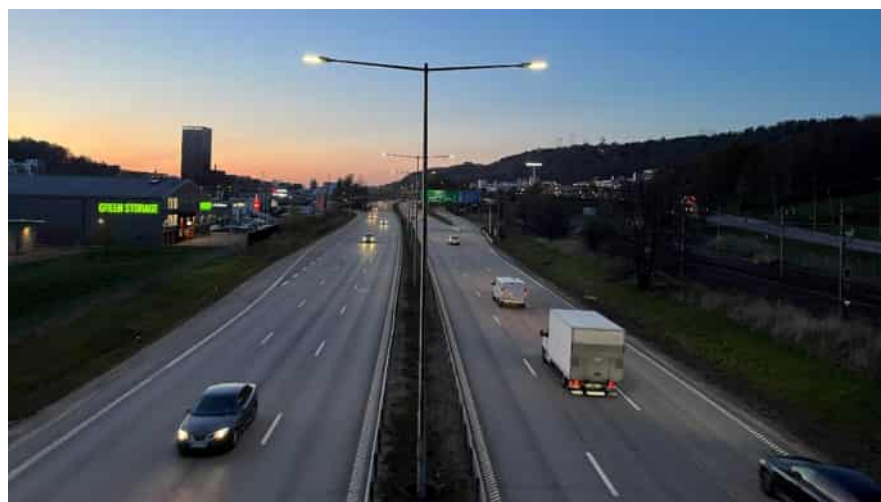
Figur 6.7.14: Hela Kungsbackaleden är belyst med armaturer monterade på dubbelarmsstolpe som är placerade i vägens mittremsa. Hela sträckningen är belyst av nyare vägbelysningsarmaturer med LED-ljuskällor och plant glas.
