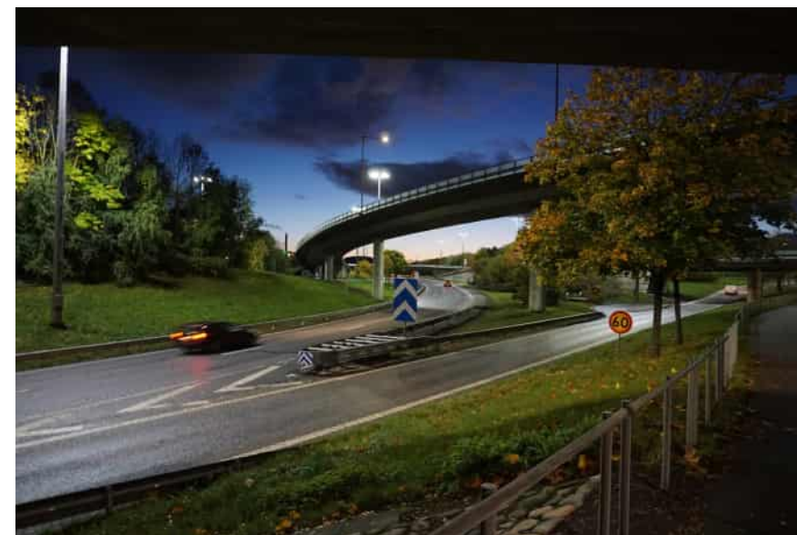
Figur 6.7.16: Höga master runt Åbromotet lyser upp även långt utanför vägen.
