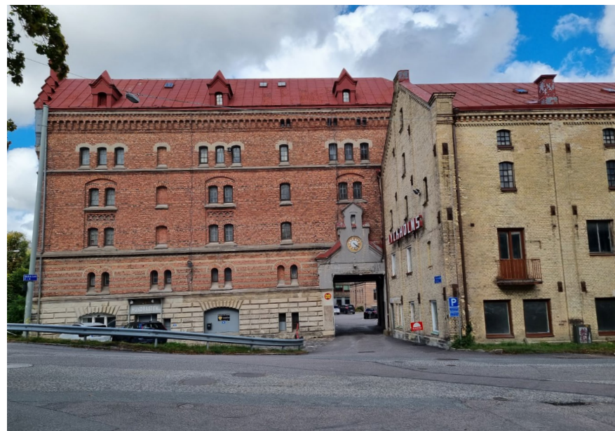
Figur 97: Fabriksbyggnader tillhörande Lyckholms bryggeri som ligger norr om järnvägskorridoren.
